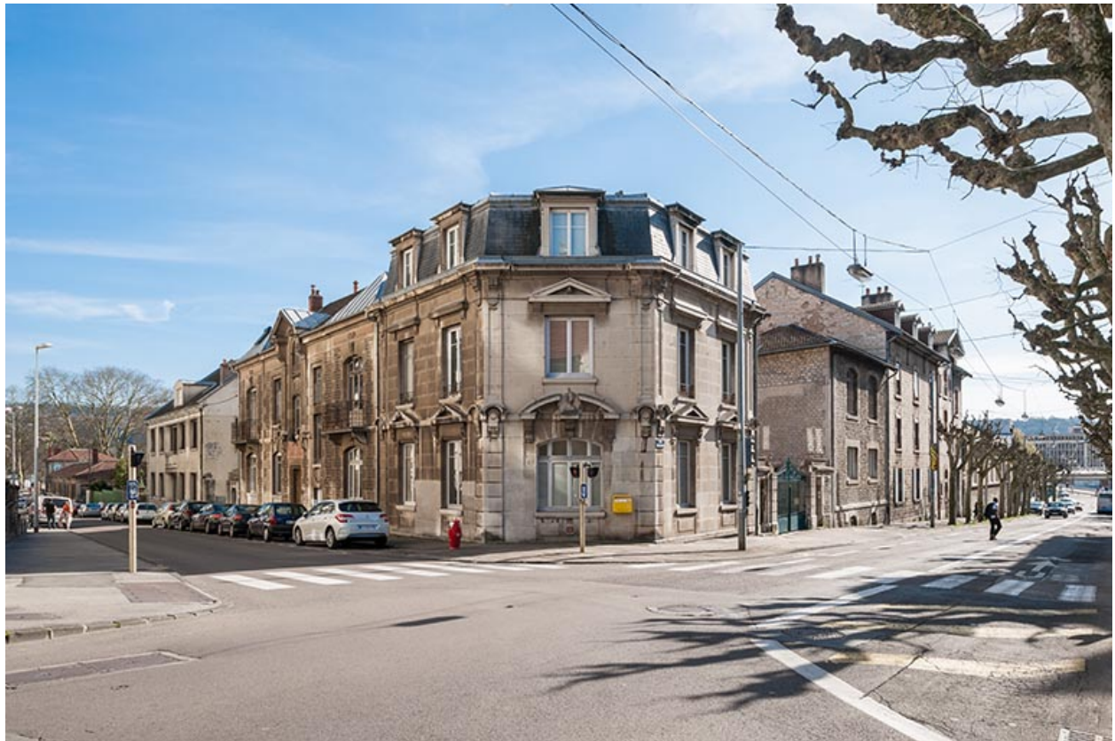
Vue d'ensemble du site, depuis le nord.
