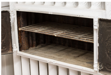
Bâtiment de l'administration, 1er étage : radiateur à chauffe- plat, détail du chauffe-plat. Phot. Jérôme Mongreville IVR43_20142500010NUC4A
