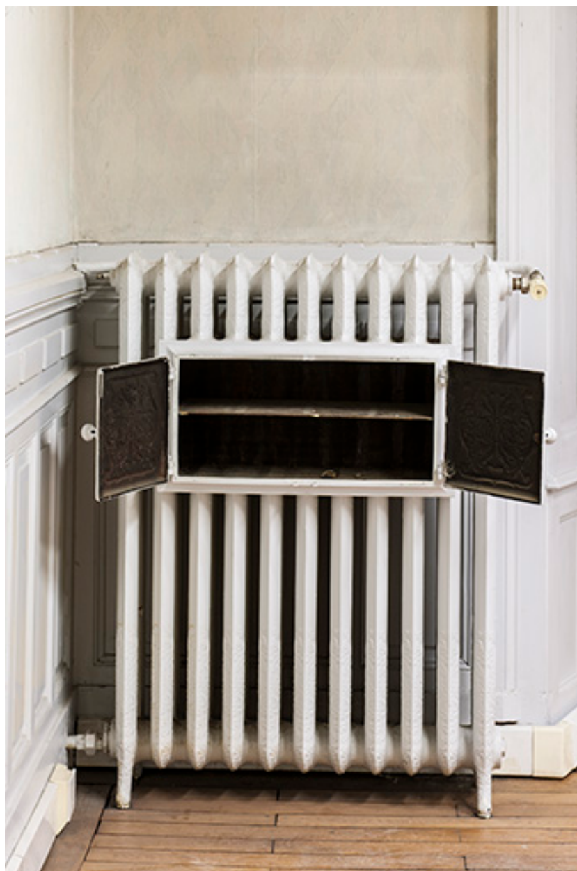
Bâtiment de l'administration, 1er étage : radiateur à chauffe-plat, avec chauffe-plat ouvert.
