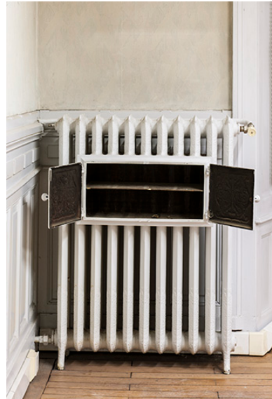
Bâtiment de l'administration, 1er étage : radiateur à chauffe- plat, avec chauffe-plat ouvert. Phot. Jérôme Mongreville IVR43_20142500009NUC4A
