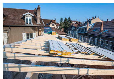
L'entrepôt en cours de surélévation en 2003 : la charpente. Phot. Jérôme Mongreville IVR43_20132502813NUC4A
