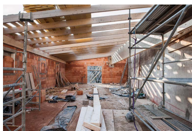
L'entrepôt en cours de surélévation en 2003 : intérieur de l'étage en surcroît depuis l'entrée. Phot. Jérôme Mongreville IVR43_20132502814NUC4A
