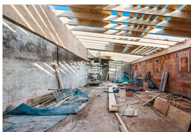
L'entrepôt en cours de surélévation en 2003 : intérieur de l'étage en surcroît depuis le fond. Phot. Jérôme Mongreville IVR43_20132502812NUC4A
