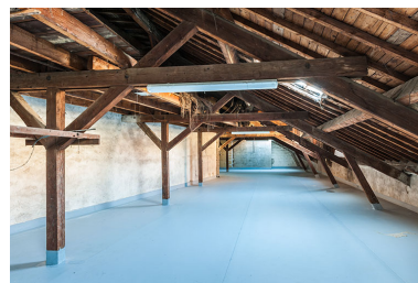
L'entrepôt en cours de surélévation en 2003 : couche d'étanchéité appliquée sur le sol de l'étage en surcroît.
