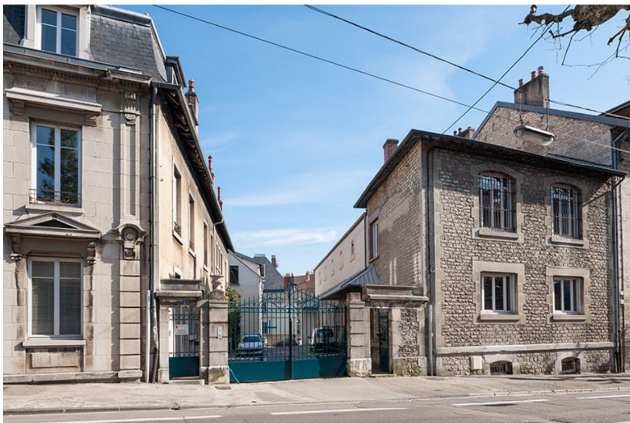
Entrée du site sur l'avenue Denfert-Rochereau.
