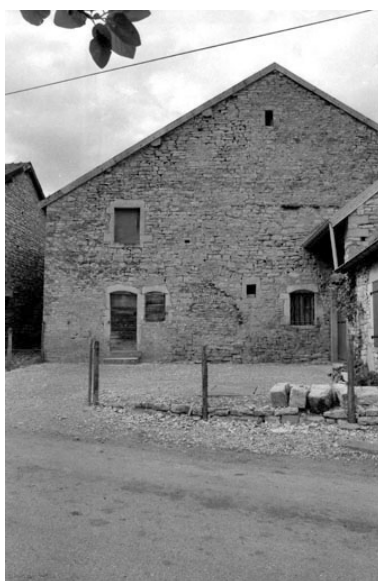
Maison située Grande Rue. Phot. Bernard Lardière IVR43_19817000546Z
