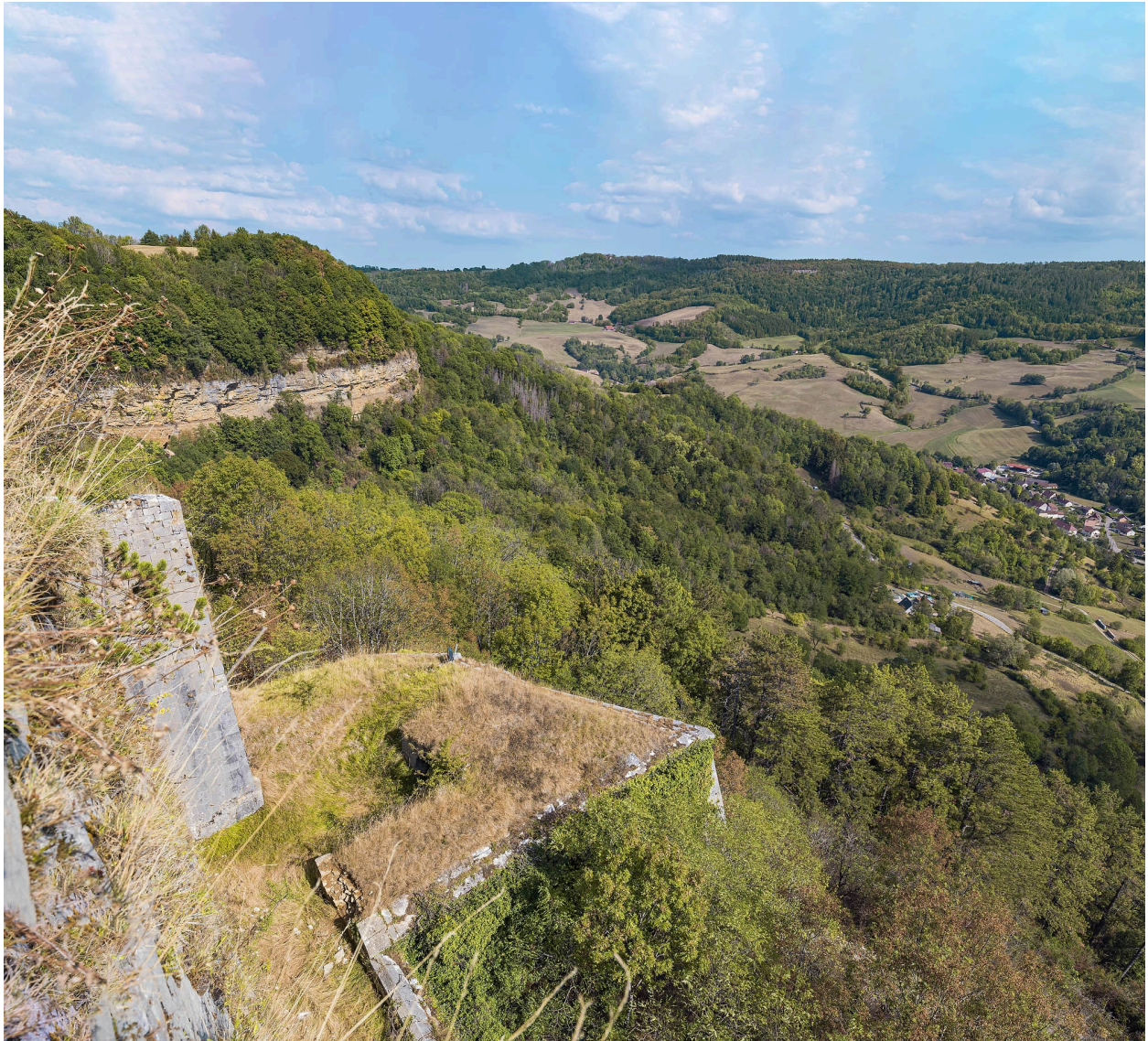
Vestige de l'ouvrage à cornes.
