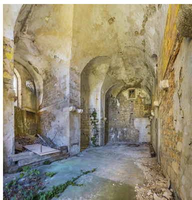
Vue intérieure du bâtiment casematé.
