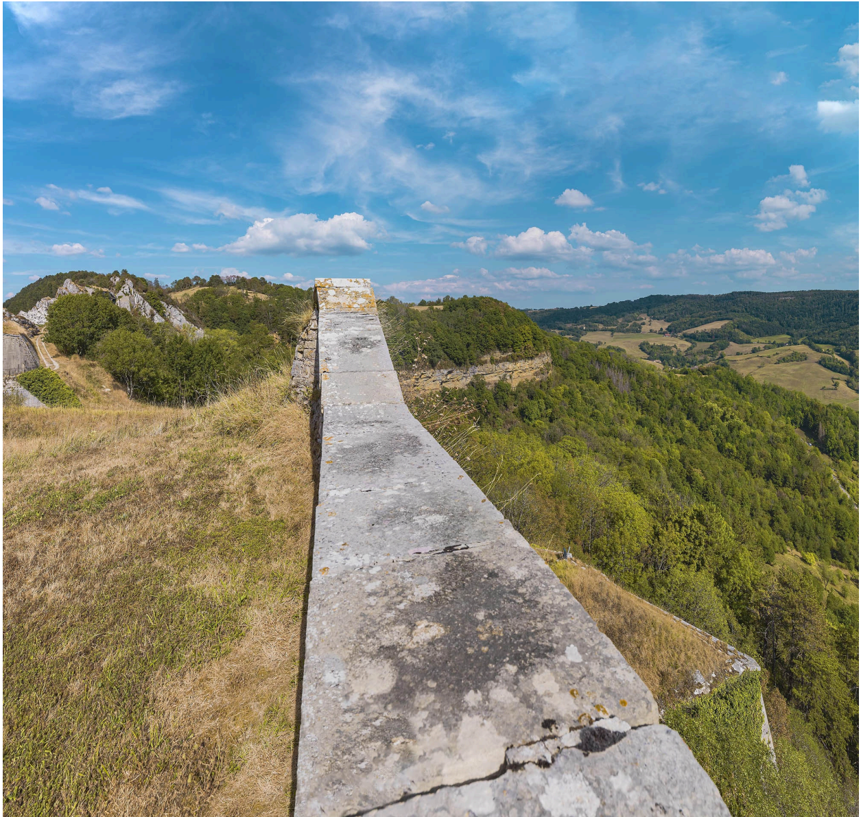
Parapet du front sud.
