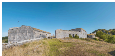
Vue générale du site depuis le sud.
