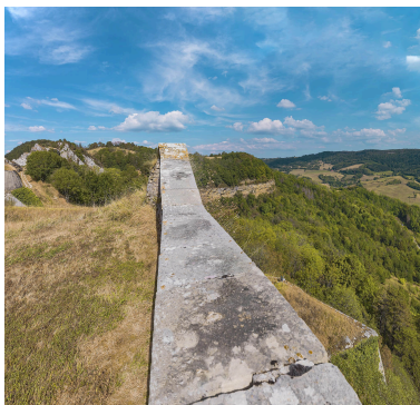
Parapet du front sud.
