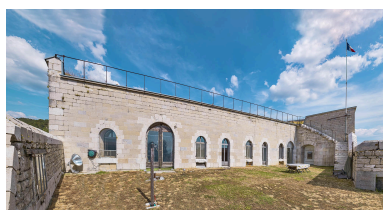
Le réduit intérieur : façade postérieure. Phot. Thierry Kuntz IVR43_20223900653NUC4A
