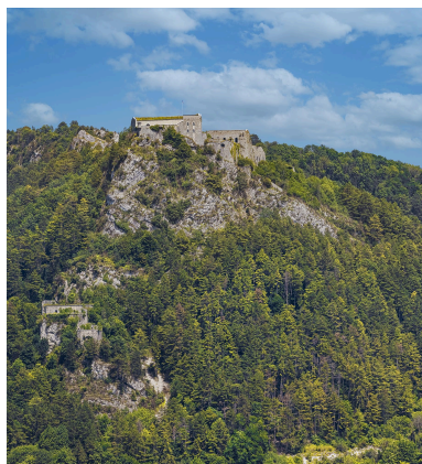
Vue générale. Phot. Thierry Kuntz IVR43_20213900092NUC4A
