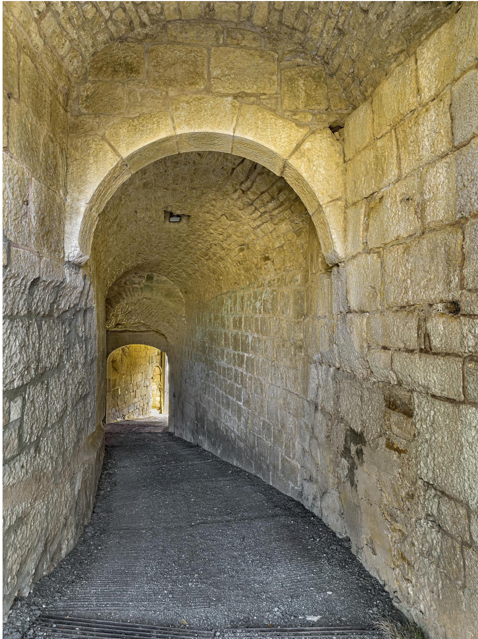
Passage intérieur du cavalier.
