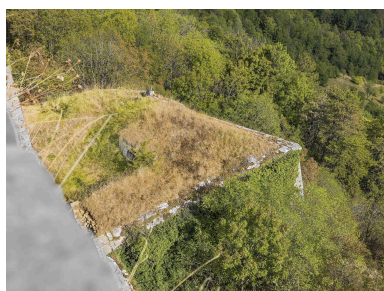
Demi-bastion de l'ouvrage à cornes.
