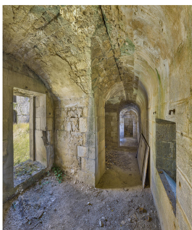
Vue intérieure de la coursière. Phot. Thierry Kuntz IVR43_20223901093NUC4A
