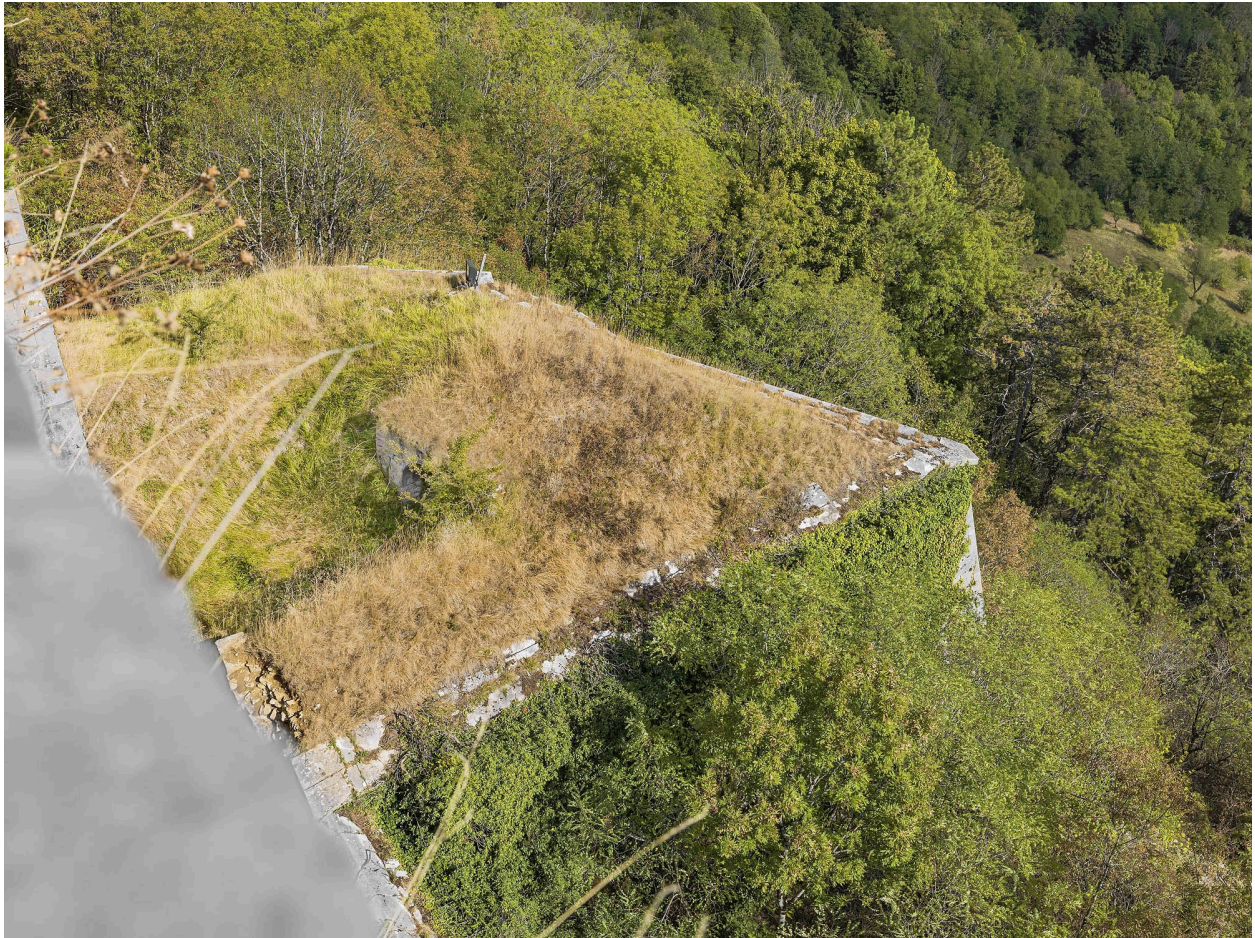
Demi-bastion de l'ouvrage à cornes.
