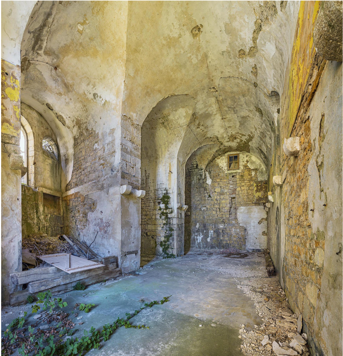
Vue intérieure du bâtiment casematé.
