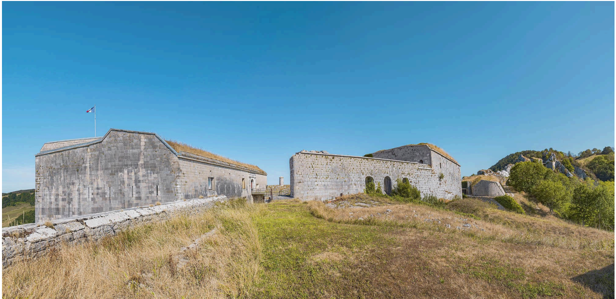
Vue générale du site depuis le sud.
