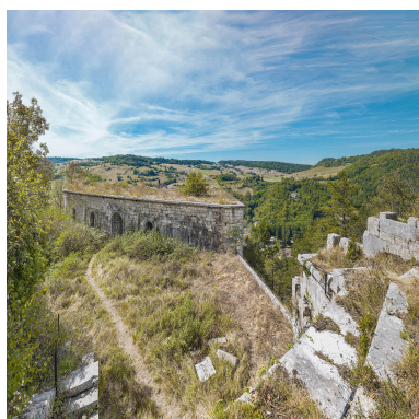
La plateforme et le réduit du bas-Belin. Phot. Thierry Kuntz IVR43_20223901140NUC4A
