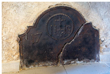
Plaque de cheminée, pièce principale.
