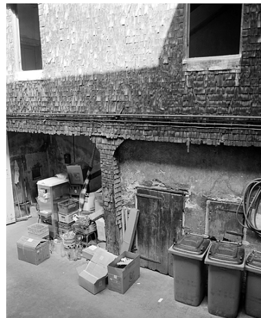
Escalier dans la cour, partie inférieure. Phot. Yves Sancey IVR43_19853900327X
