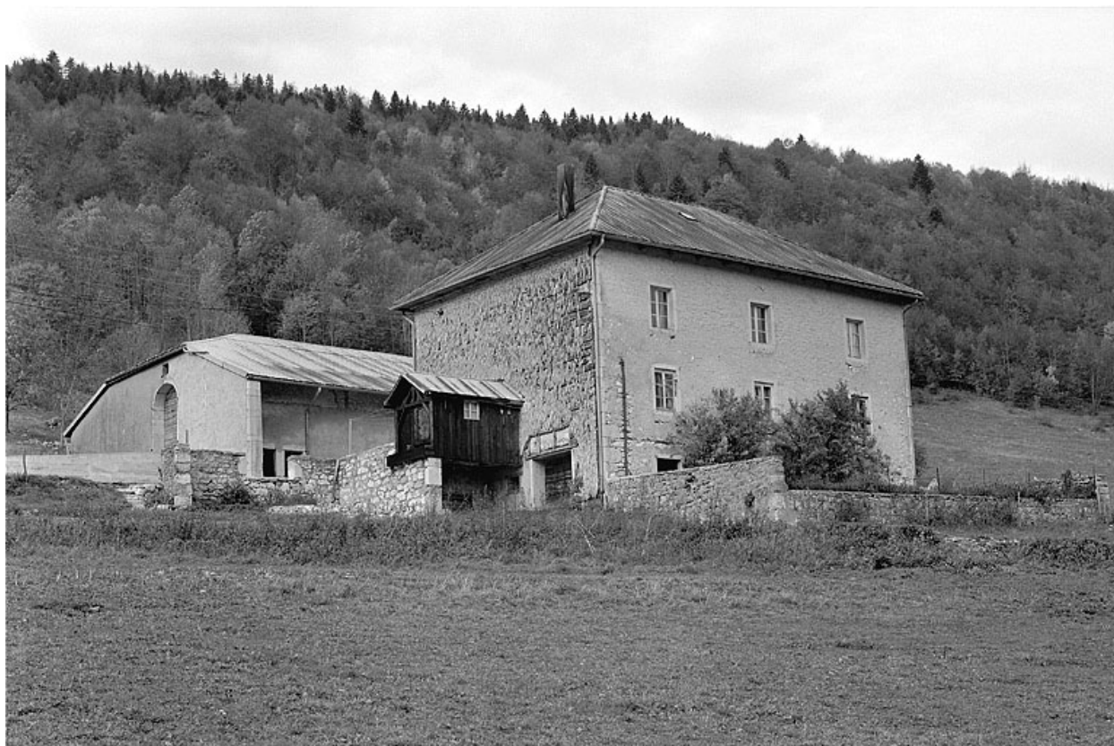
Face sud-ouest et façade postérieure.
