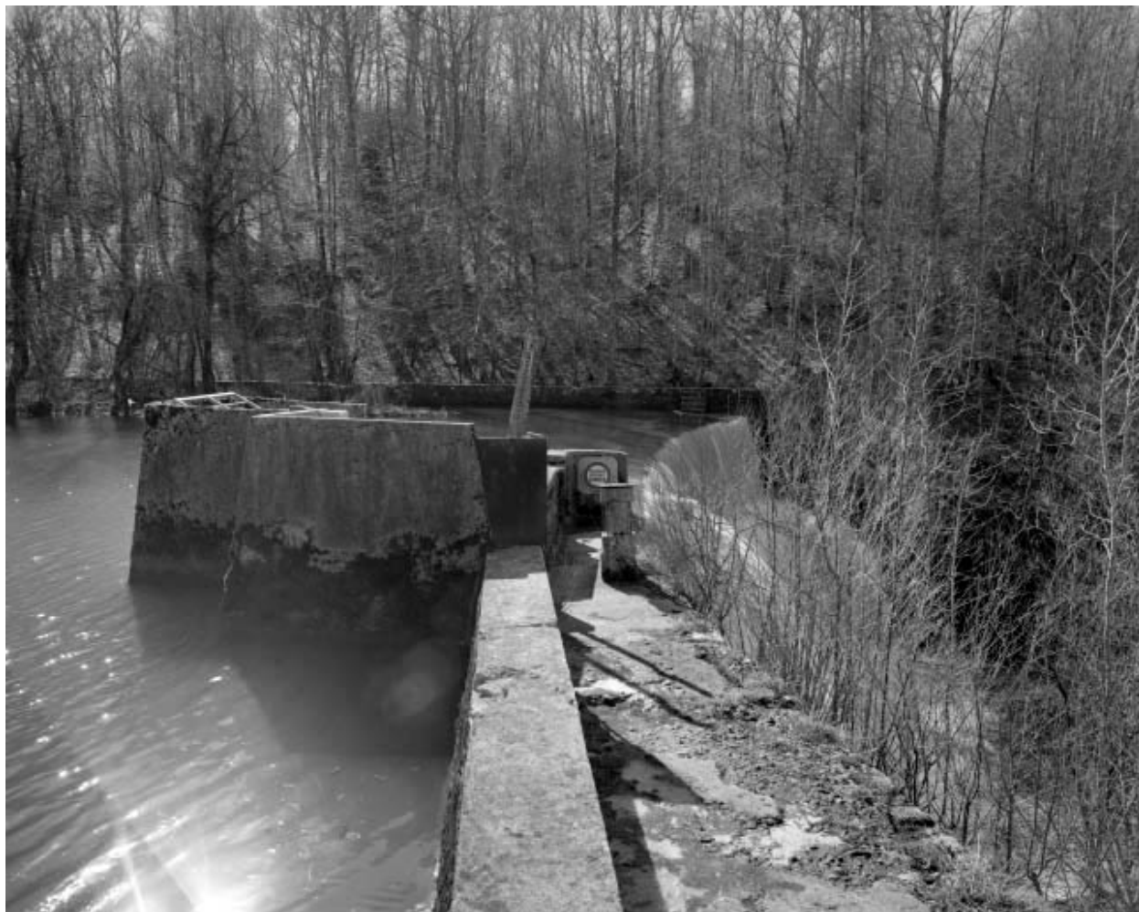
Tour de prise d'eau et barrage.
