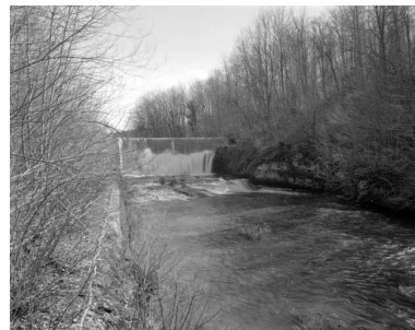
Barrage à crête déversante sur l'Angillon.
