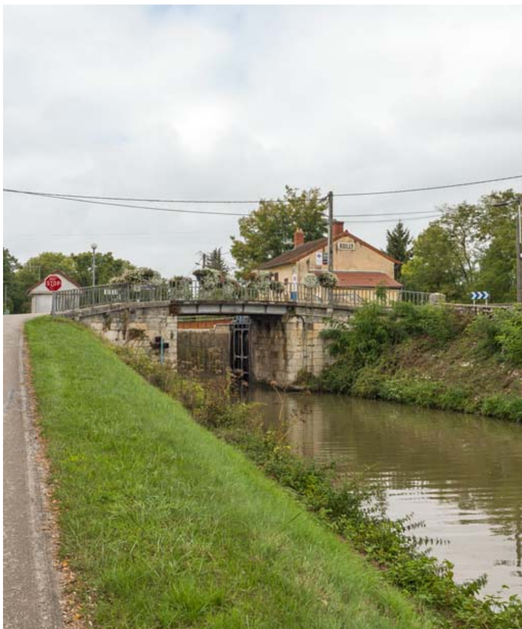
Vue d'ensemble du pont.
