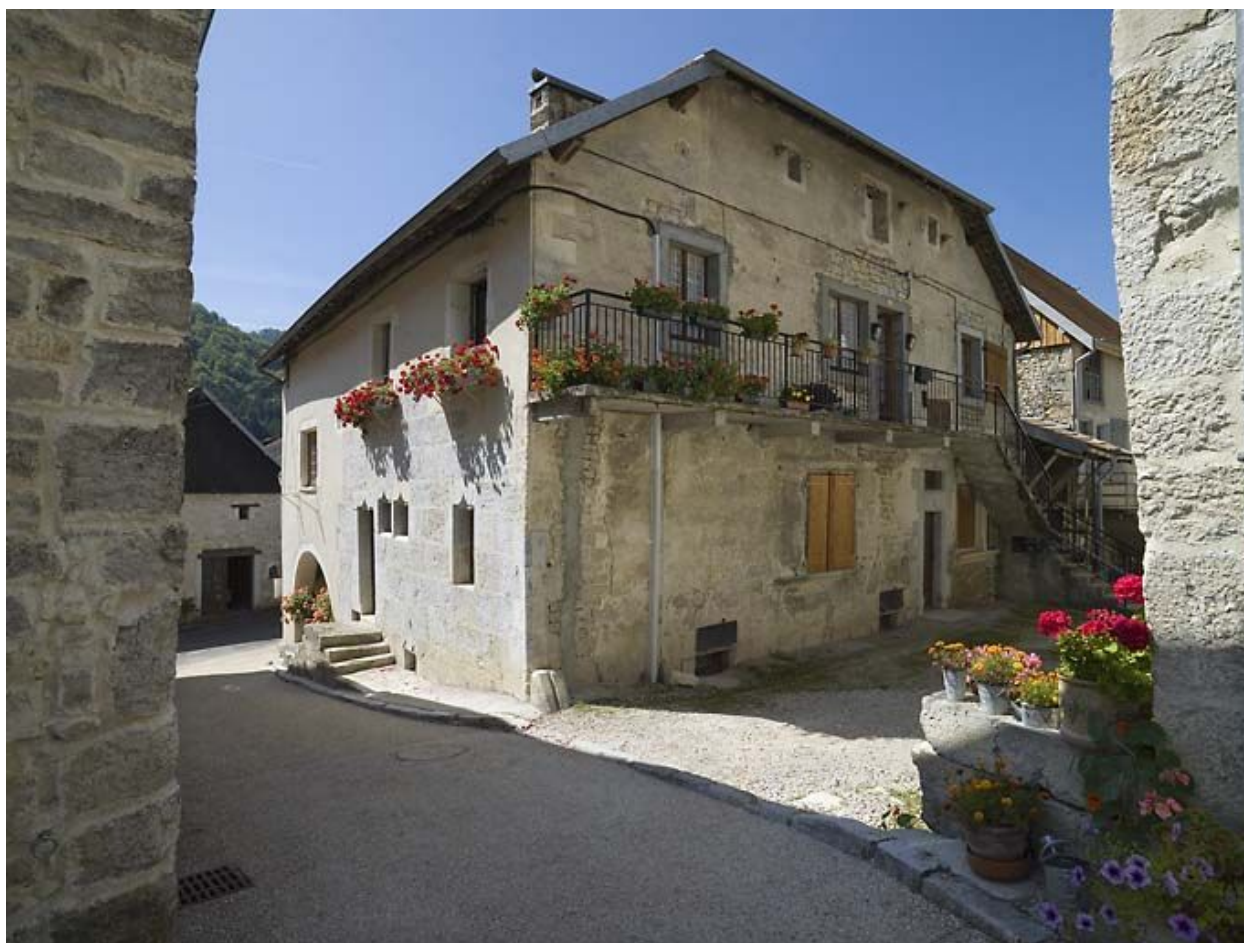
Façades antérieure et latérale droite.
