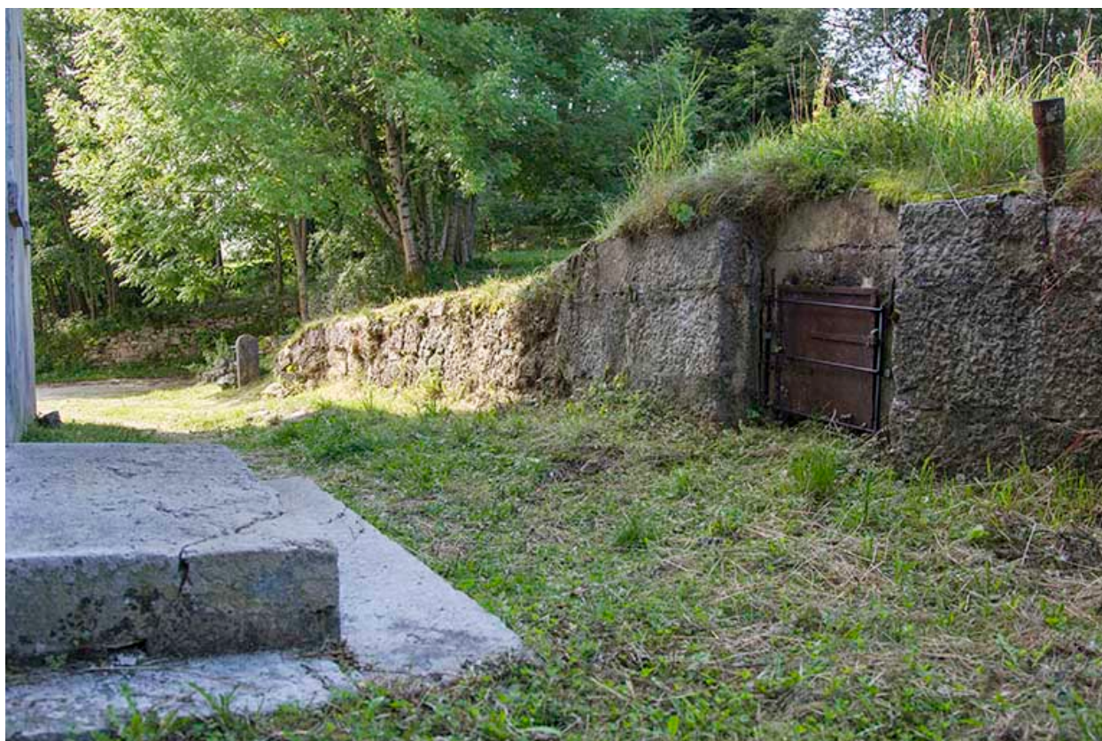
Citerne près de la façade postérieure.
