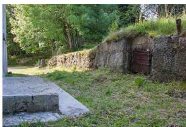
Citerne près de la façade postérieure. Phot. Sonia Dourlot IVR43_20152500813NUC2A
