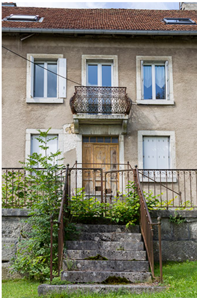
Façade antérieure : travées centrale et terrasse.
