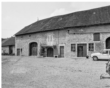
Ferme située 169 rue Saint-Néron. Phot. Yves Sancey IVR43_19843900060X
