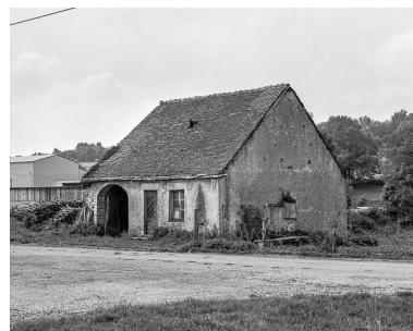
Ferme située 580 rue Saint-Néron Phot. Yves Sancey IVR43_19843900065X
