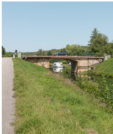
Vue du pont.
