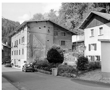
Elévation latérale droite. Phot. Yves Sancey IVR43_20033900080X
