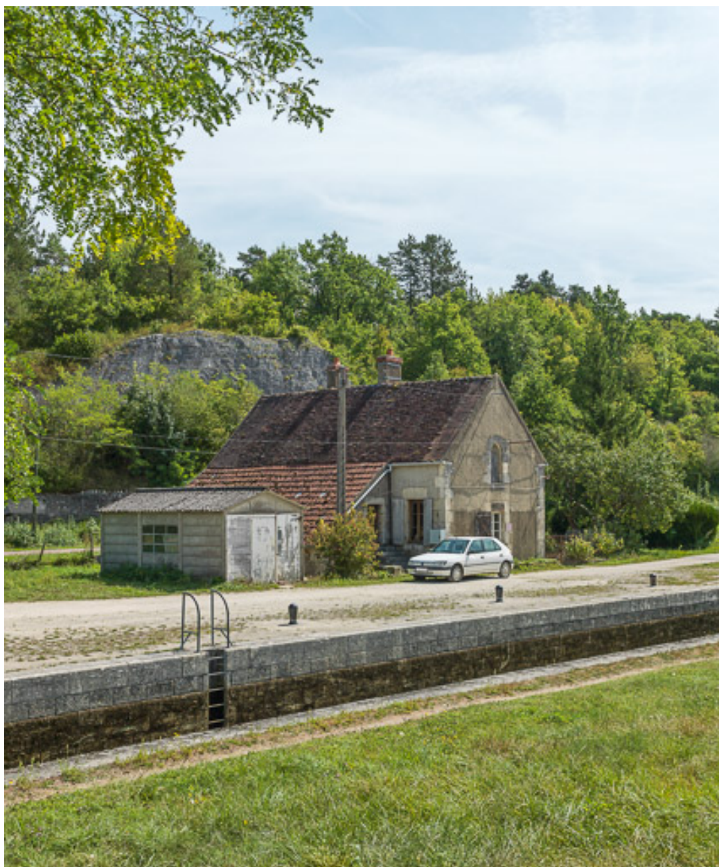
Vue de la maison éclusière.
