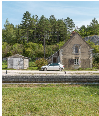
Vue de la maison éclusière.
