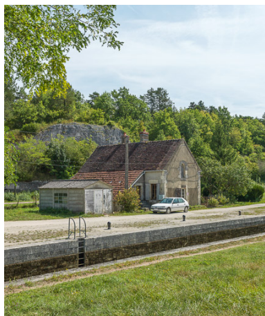
Vue de la maison éclusière.
