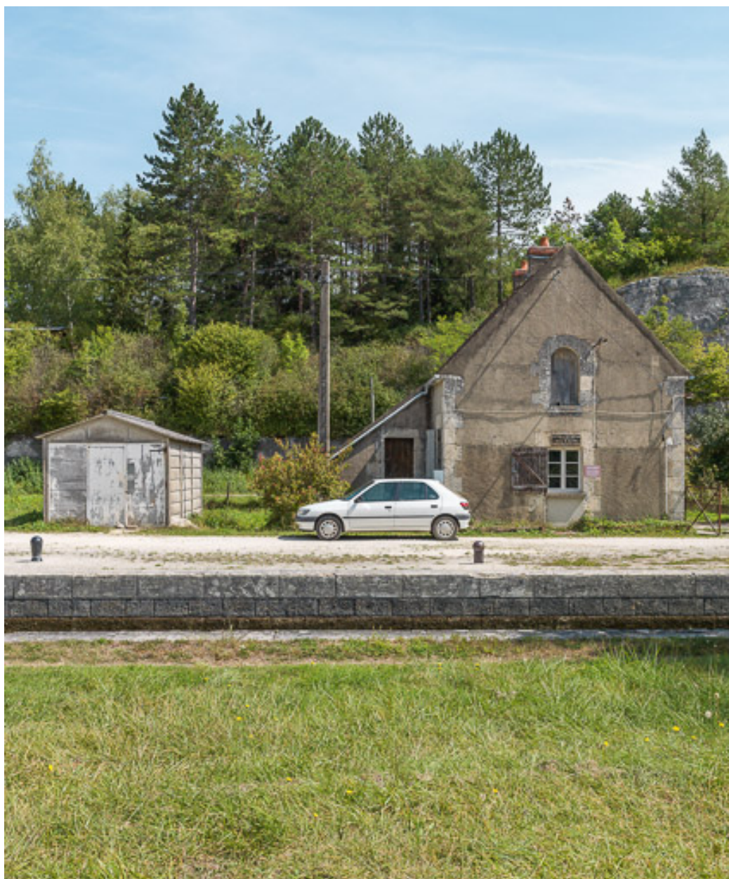
Vue de la maison éclusière.
