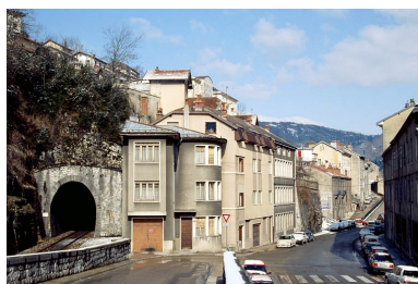
Vue d'ensemble des bâtiments n ° 23 et 25 (ateliers de fabrication). Phot. Laurent Poupard IVR43_19923901371ZA
