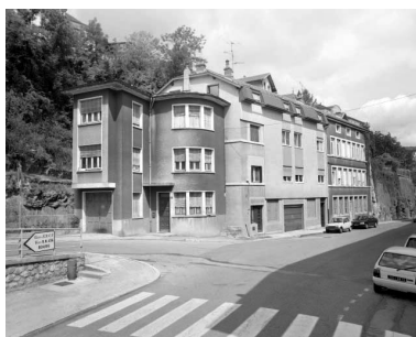
Bâtiments n° 23 et 25 de trois quarts gauche. Phot. Jérôme Mongreville IVR43_19923900719X
