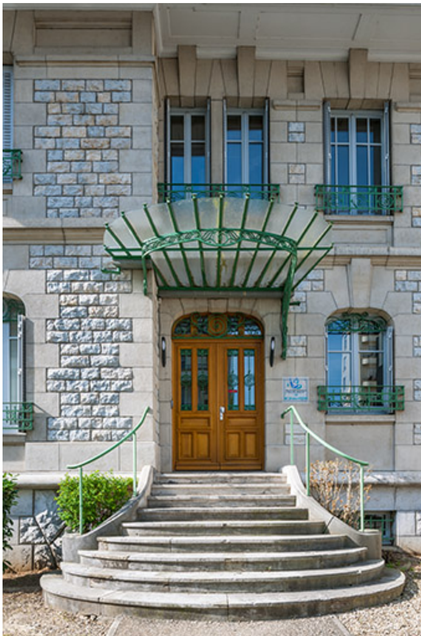
Façade antérieure : perron, entrée et marquise.
