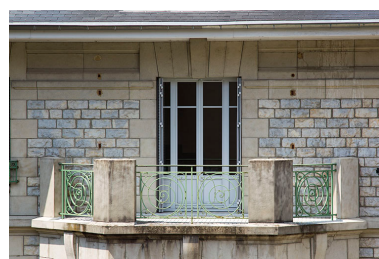
Façade latérale gauche : terrasse surmontant le bow-window. Phot. Jérôme Mongreville IVR43_20142500516NUC2A
