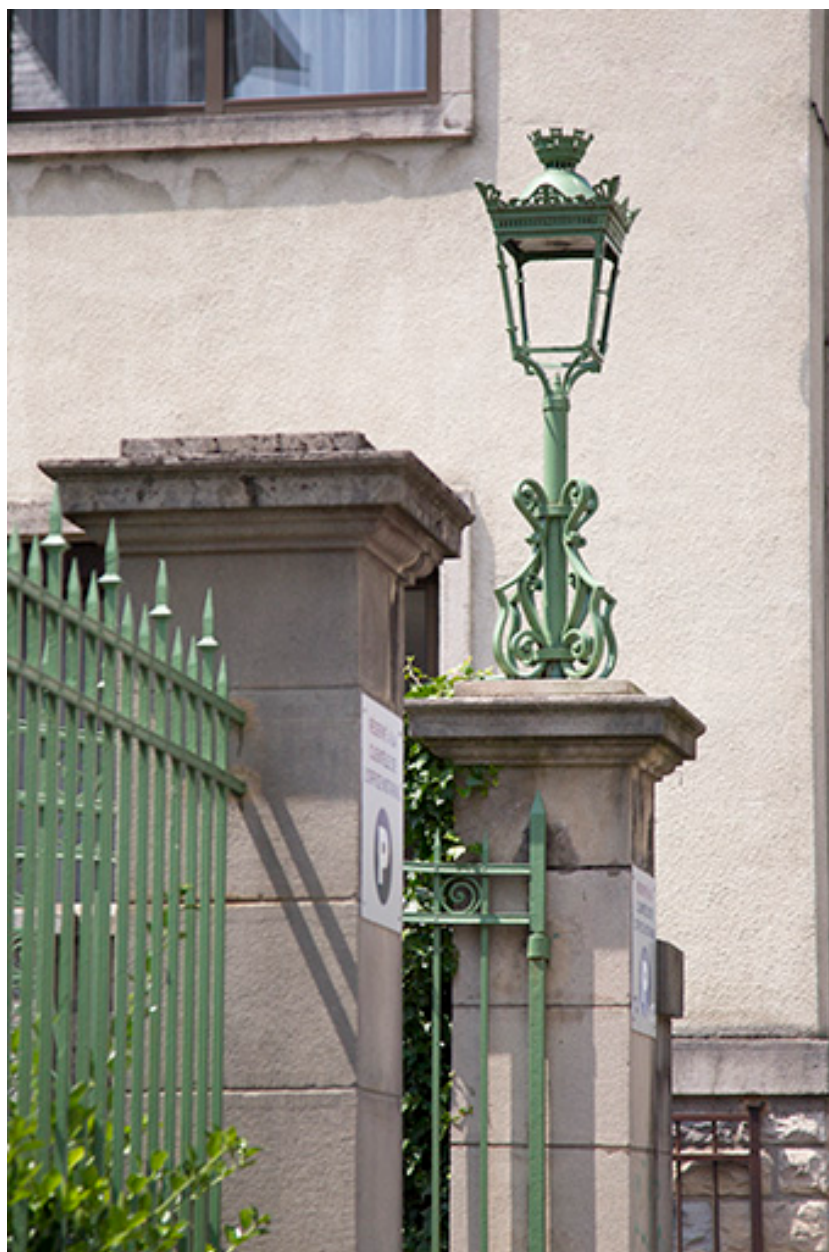
Portail : piliers, grille et luminaire.
