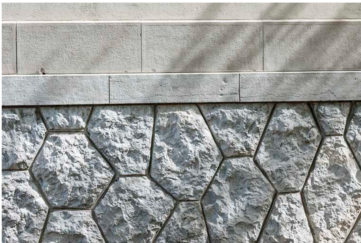
Façade postérieure : détail de l'appareil du soubassement.
