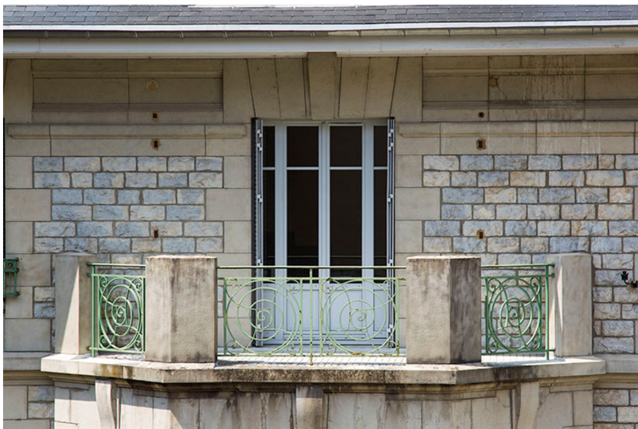
Façade latérale gauche : terrasse surmontant le bow-window.
