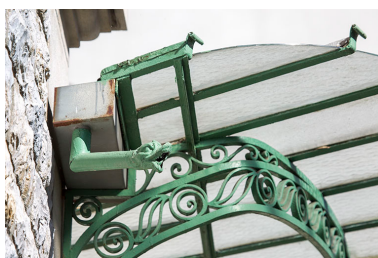
Façade antérieure : ferronnerie et gargouille de la marquise (côté gauche). Phot. Jérôme Mongreville IVR43_20142500523NUC2A
