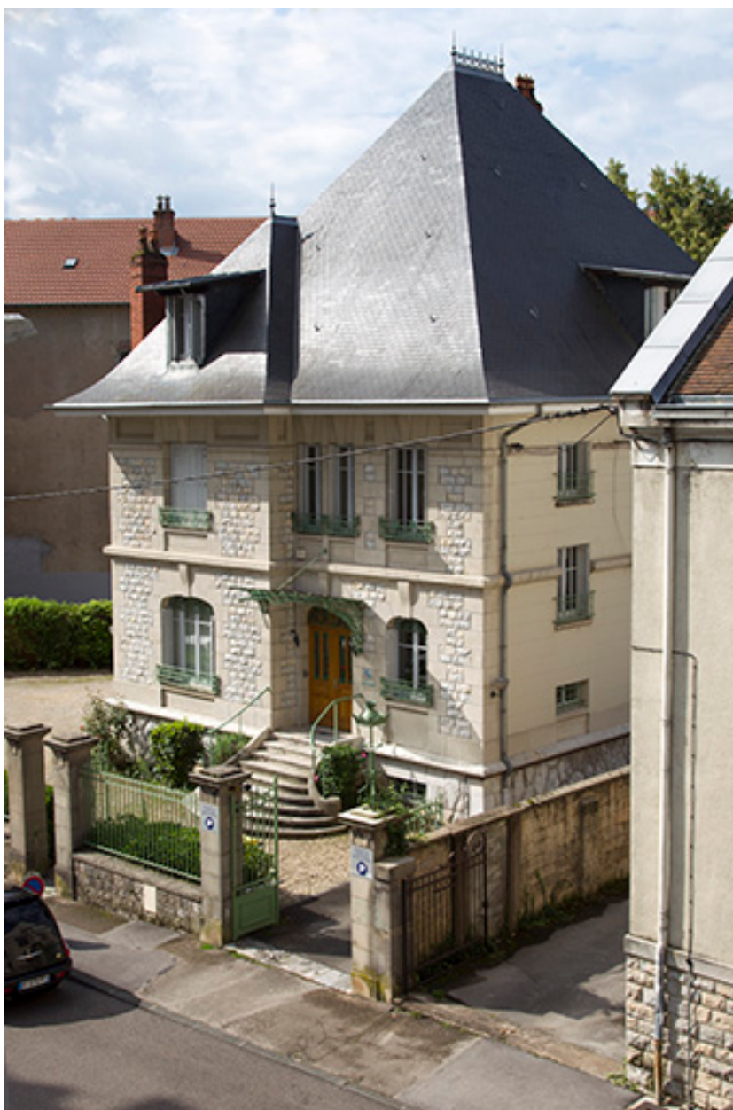
Vue plongeante sur la façade antérieure.
