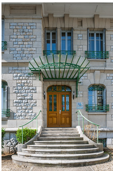
Façade antérieure : perron, entrée et marquise. Phot. Jérôme Mongreville IVR43_20142500486NUC4A
