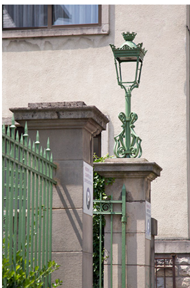
Portail : piliers, grille et luminaire. Phot. Jérôme Mongreville
