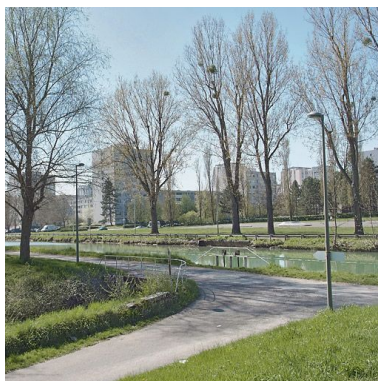
Les vannes du déversoir. Phot. Thierry Kuntz IVR26_20112102628NUC2A
