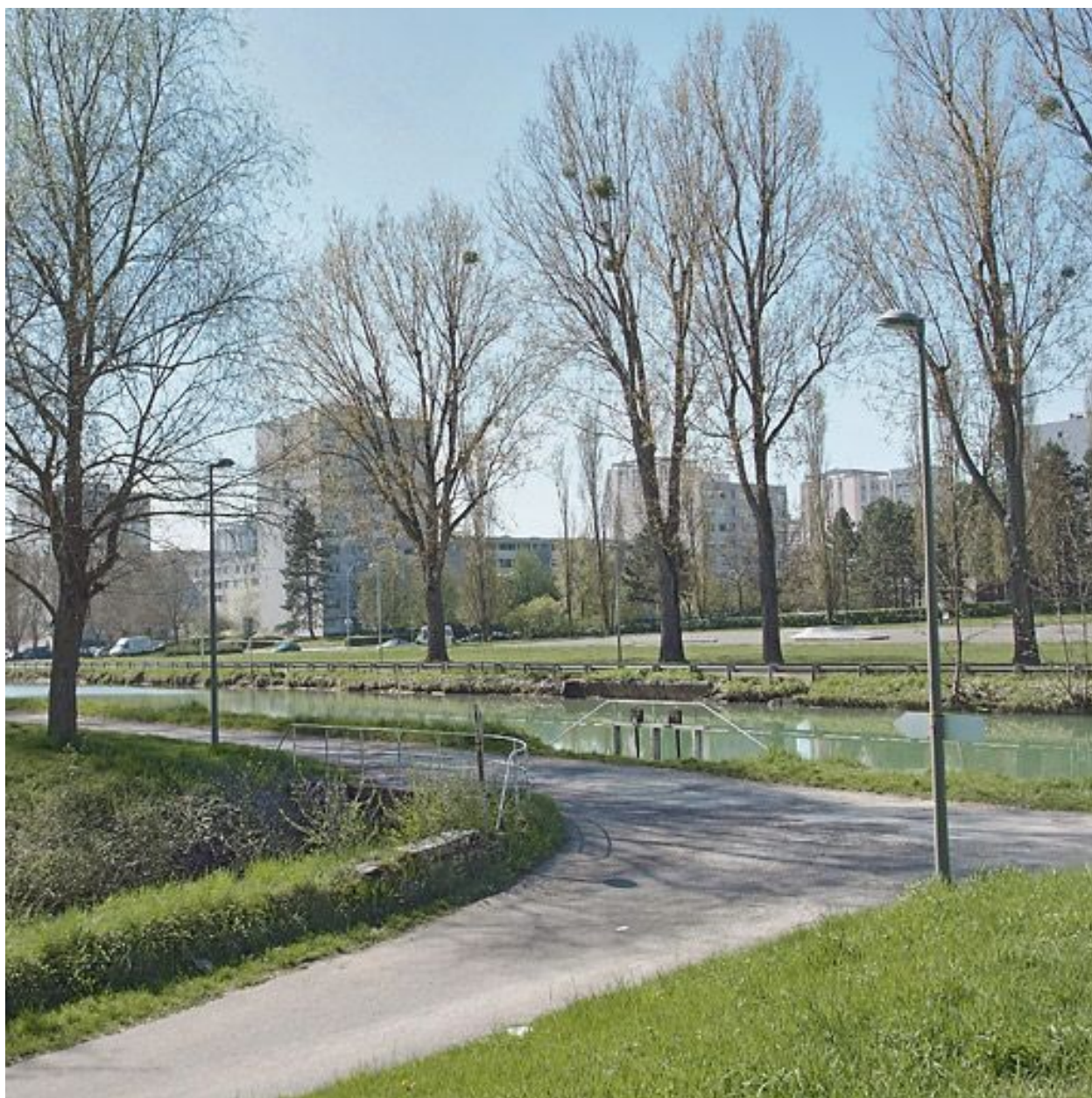
Les vannes du déversoir.
