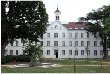
Bâtiment central. Phot. Alain Morelière IVR26_20118900019NUC2A
