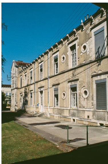
Quartier des femmes, bâtiment des pensionnaires. Phot. Jean-Luc Duthu IVR26_20018900125ZA
