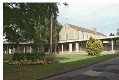
Galleries de liaison. Phot. Jean-Luc Duthu IVR26_20018900129ZA
