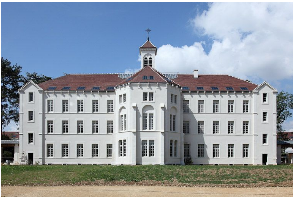
Bâtiment central, façade postérieure.
