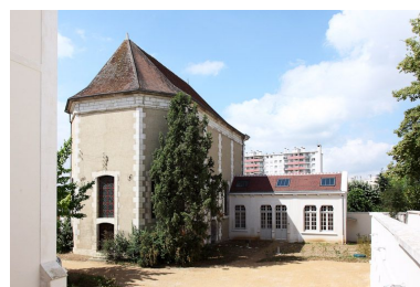
Chevet de la chapelle et sacristie. Phot. Alain Morelière IVR26_20118900022NUC2A
