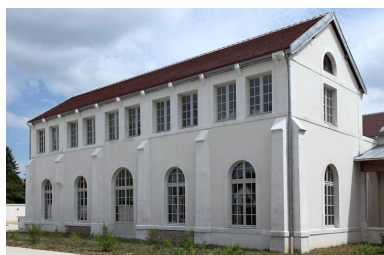
Ancienne buanderie. Phot. Alain Morelière IVR26_20118900036NUC2A
