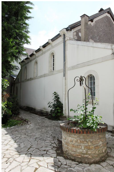
Puits de la première cour à droite. Phot. Alain Morelière IVR26_20118900023NUC2A
