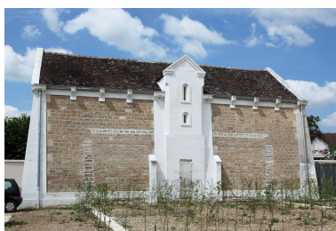
Le réservoir, façade sur cour. Phot. Alain Morelière IVR26_20118900037NUC2A
