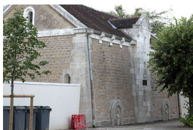
Le réservoir, façade sur rue. Phot. Alain Morelière IVR26_20118900012NUC2A
