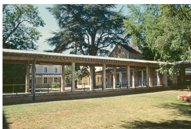
Galleries de liaison. Phot. Jean-Luc Duthu IVR26_20018900127ZA
