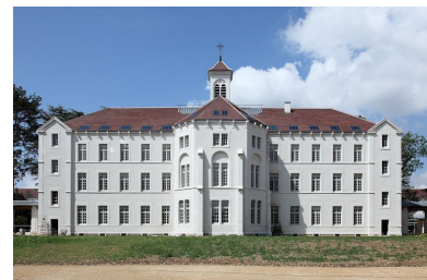
Bâtiment central, façade postérieure. Phot. Alain Morelière IVR26_20118900029NUC2A
