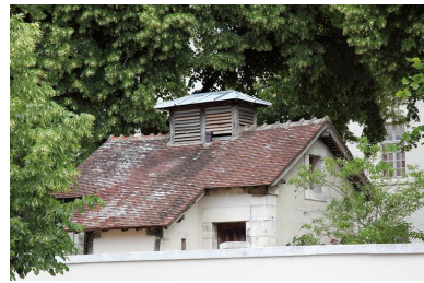
Petite dépendance vue de la rue. Phot. Alain Morelière IVR26_20118900039NUC2A
