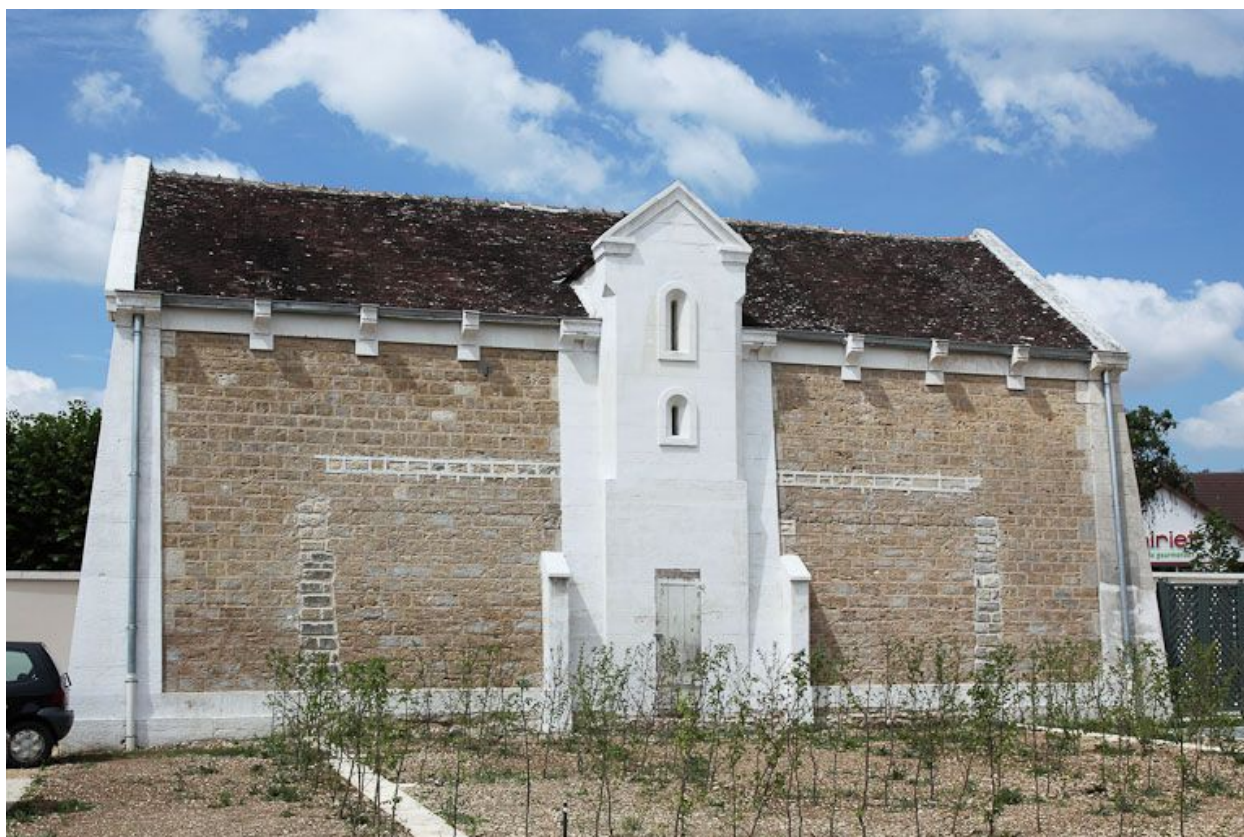
Le réservoir, façade sur cour.
