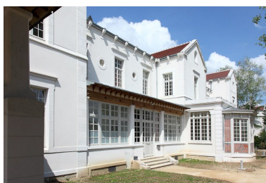
Façade est d'un des bâtiments postérieurs. Phot. Alain Morelière IVR26_20118900028NUC2A
