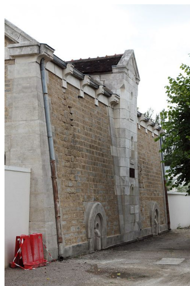
Le réservoir, façade sur rue. Phot. Alain Morelière IVR26_20118900014NUC2A
