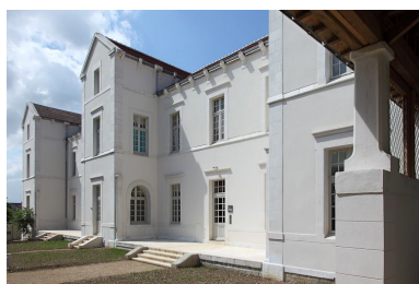
Façade est d'un des bâtiments postérieurs. Phot. Alain Morelière IVR26_20118900027NUC2A
