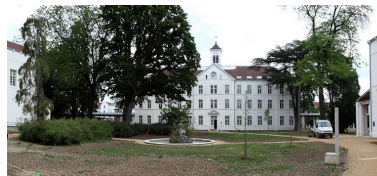
Vue d'ensemble depuis l'entrée. Phot. Alain Morelière IVR26_20118900040NUC2A
