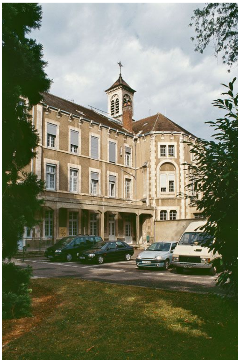
Bâtiment central, façade postérieure avec galerie en 2001.
