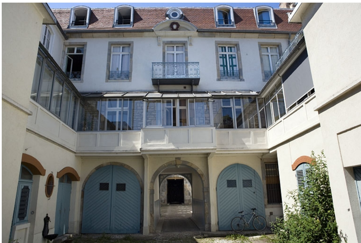
Façade postérieure du logis secondaire, de face.
