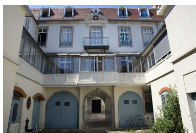
Façade postérieure du logis secondaire, de face.
