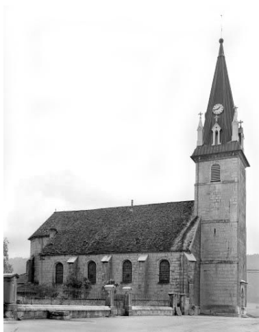
Façade laérale gauche. Phot. Yves Sancey IVR43_19782500109V
