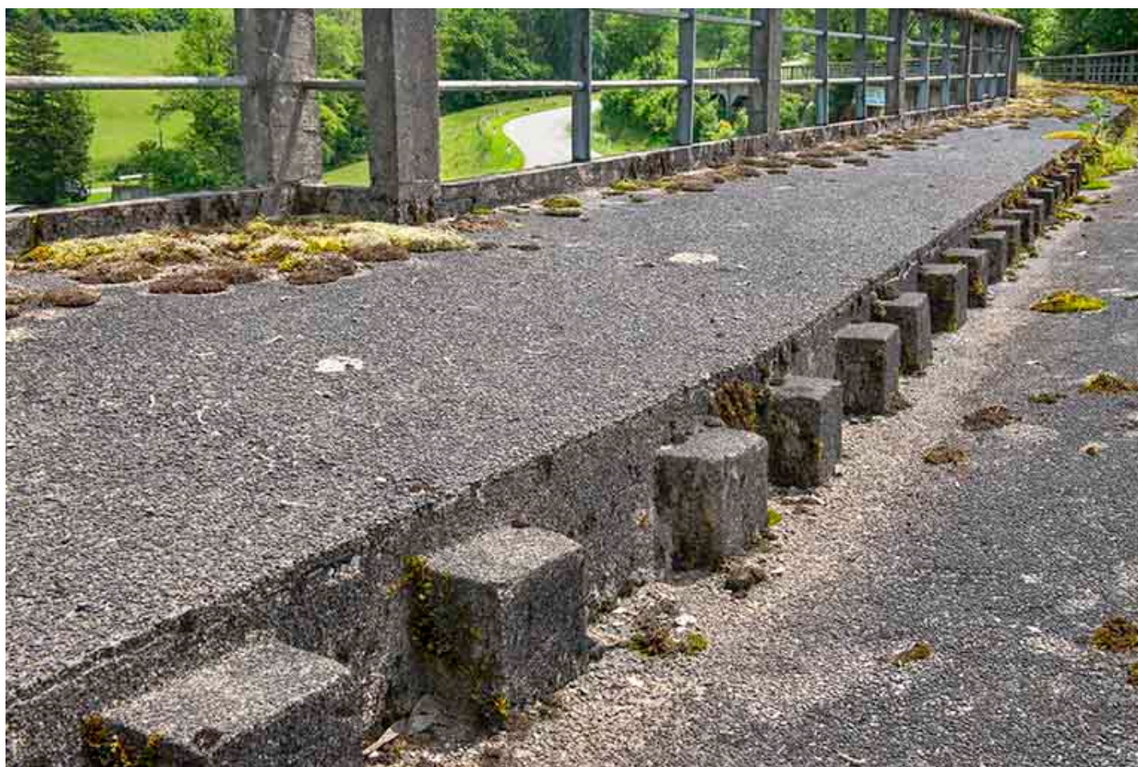
Détail du trottoir et de la chaussée.
