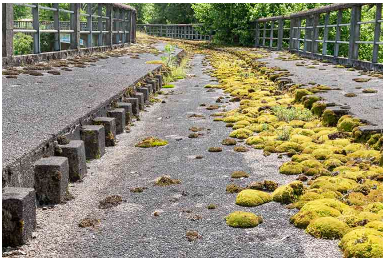
Détail de la chaussée.
