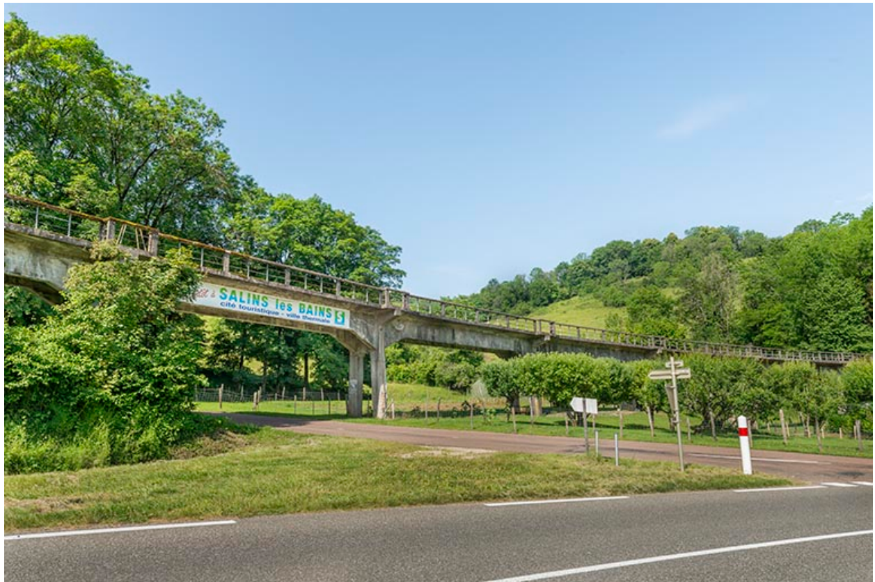
Vue d'ensemble depuis la route départementale 467.
