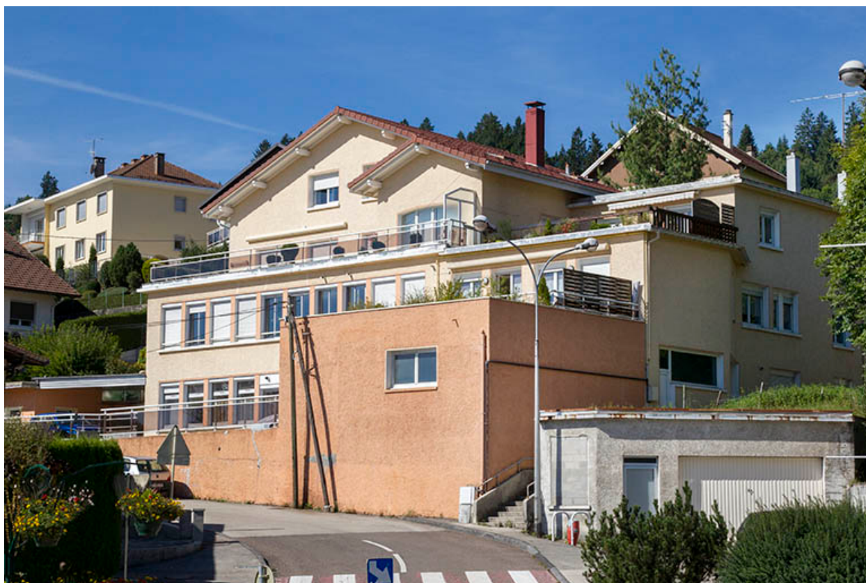
Façades antérieure et latérale droite.
