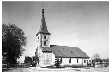
Vue générale. Phot. Yves Sancey IVR43_19812500034V
