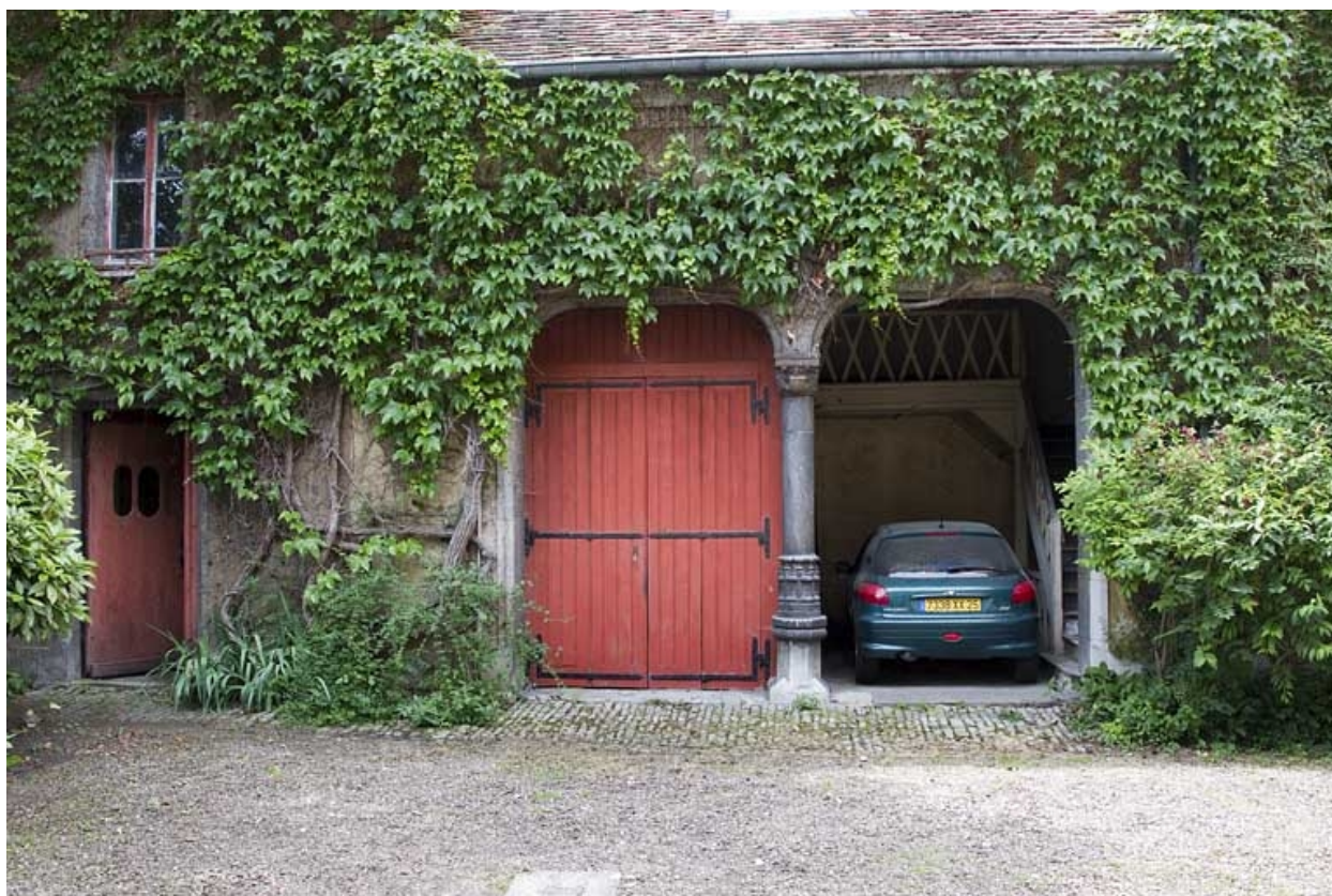
Bâtiment des remises : façade antérieure.
