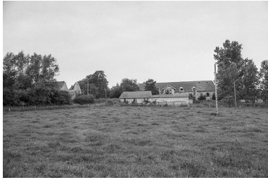
Vue d'ensemble depuis la route. Phot. Bernard Lardière IVR43_19817000387Z
