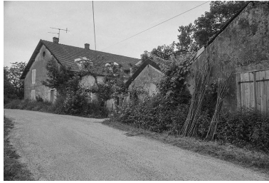
Vue d'ensemble depuis le chemin. Phot. Bernard Lardière IVR43_19817000388Z
