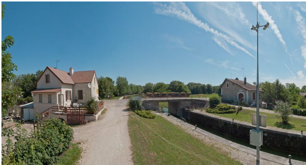
Vue d'ensemble du site d'écluse.
