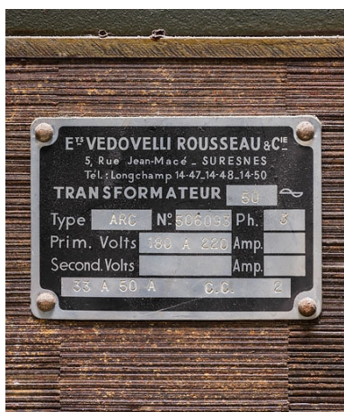
Redresseur Rectarc désaffecté : plaque de constructeur sur l'un des éléments. Phot. Pierre-Marie Barbe-Richaud IVR26_20222100064NUC2A
