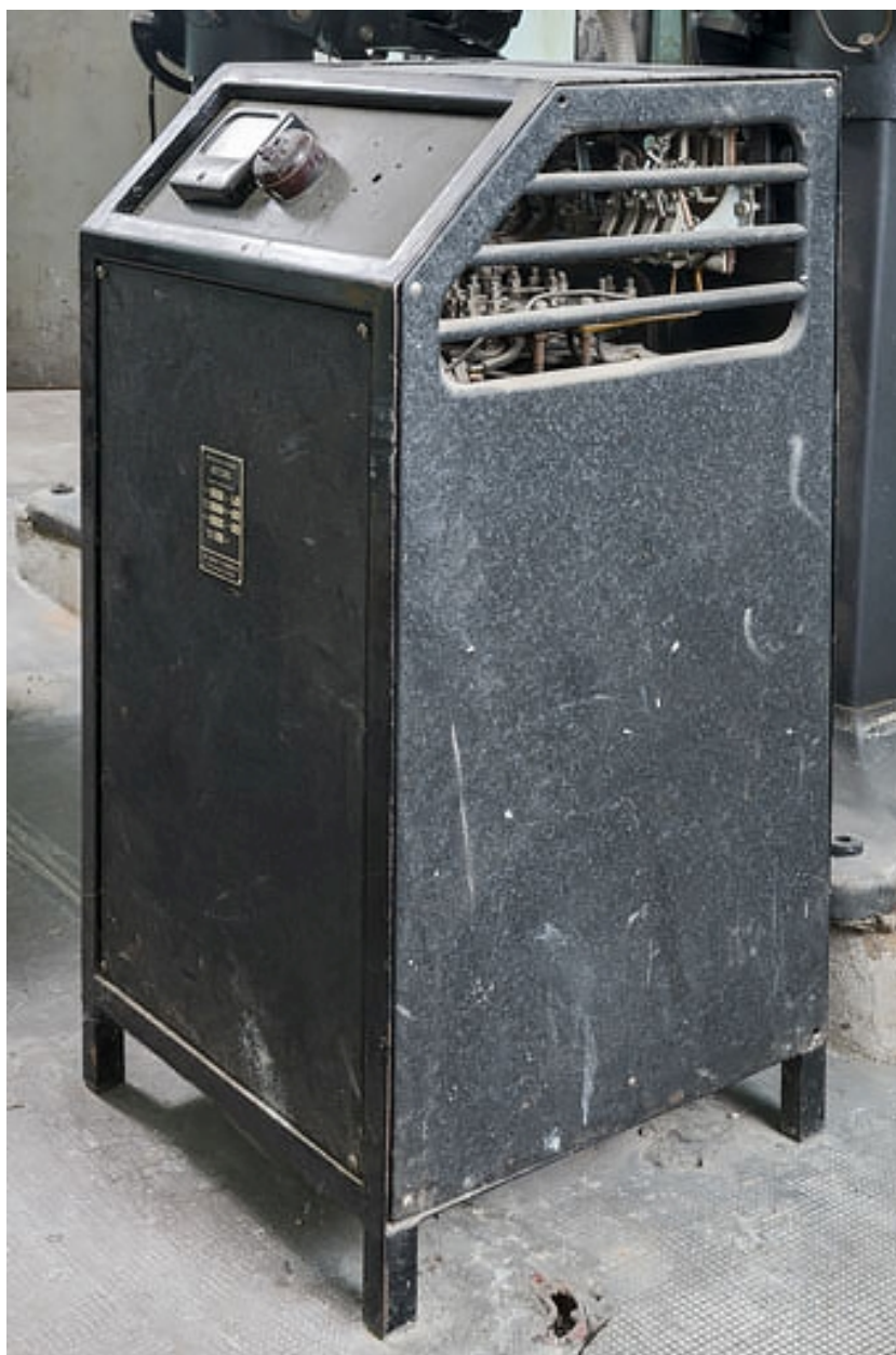
Redresseur Rectarc désaffecté.
