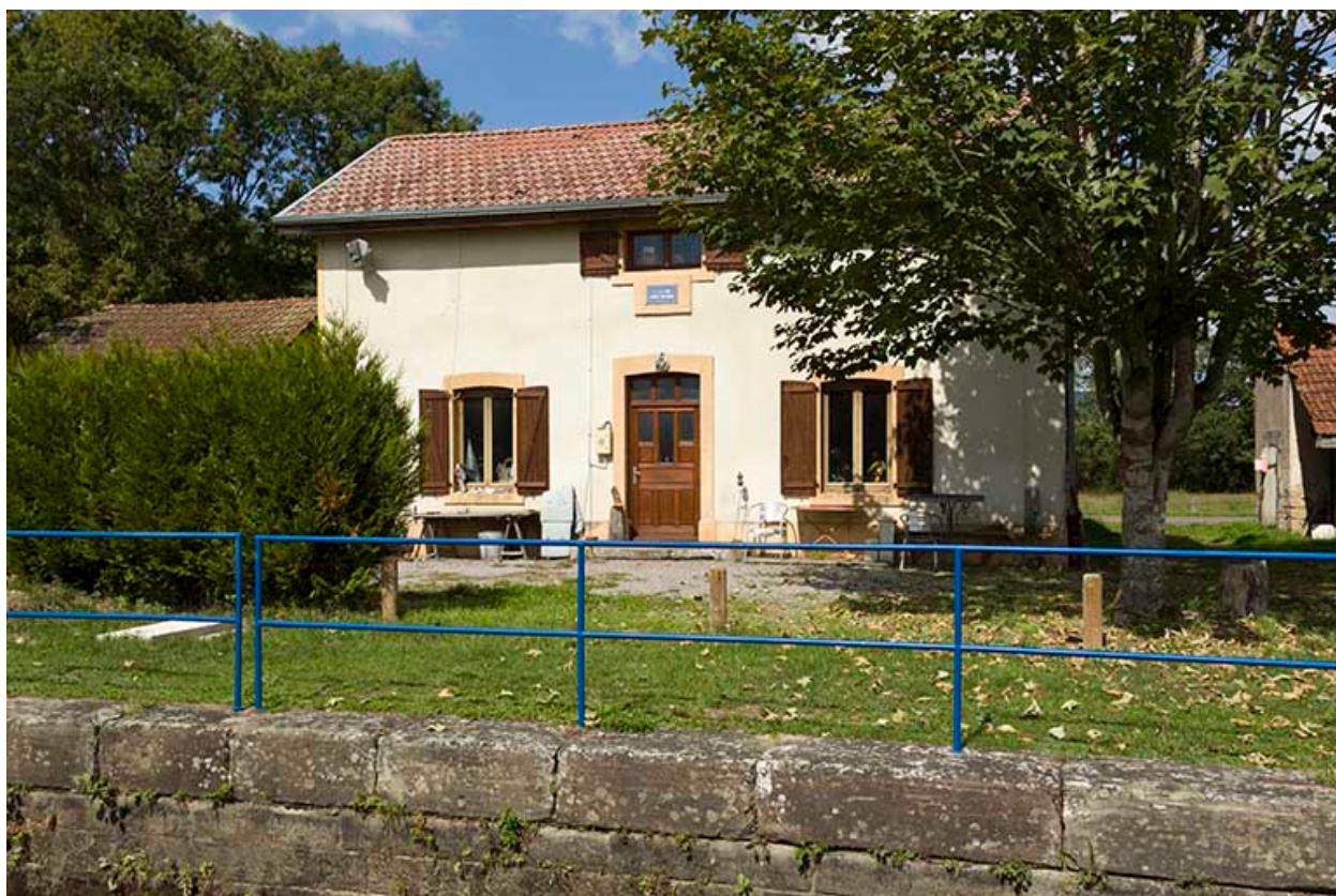
La maison d'éclusier, depuis l'écluse.
