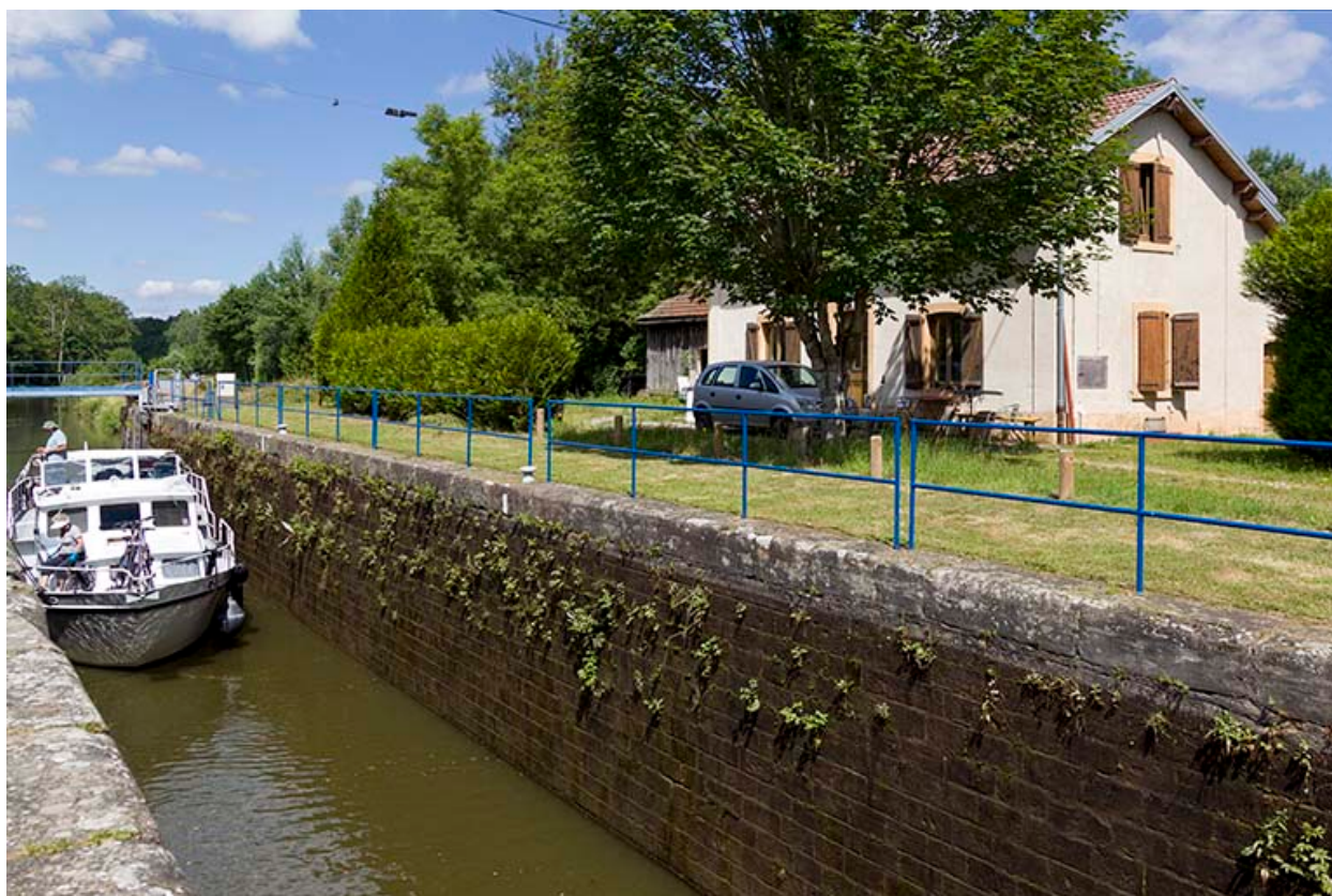
l'écluse à sas.
