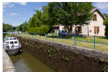
l'écluse à sas. Phot. Sonia Dourlot IVR43_20157000903NUC2A
