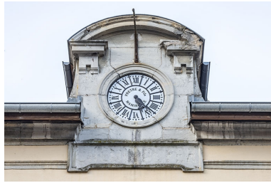
Horloge de la façade est. Phot. Jérôme Mongreville IVR43_20223900278NUC4A
