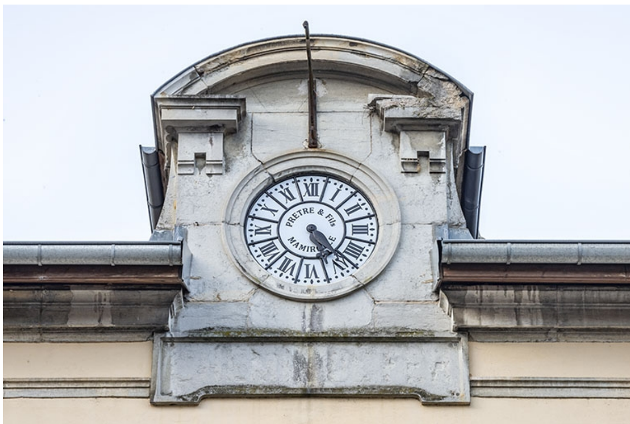
Horloge de la façade est.
