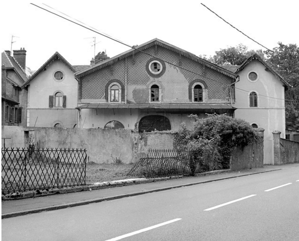
Façade postérieure de la ferme.
