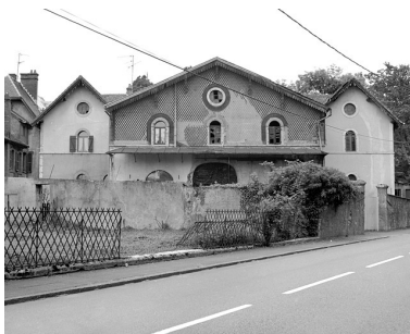
Façade postérieure de la ferme. Phot. Yves Sancey IVR43_20029000286X
