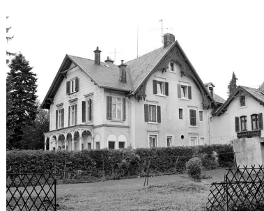
Façade orientale du logement principal.
