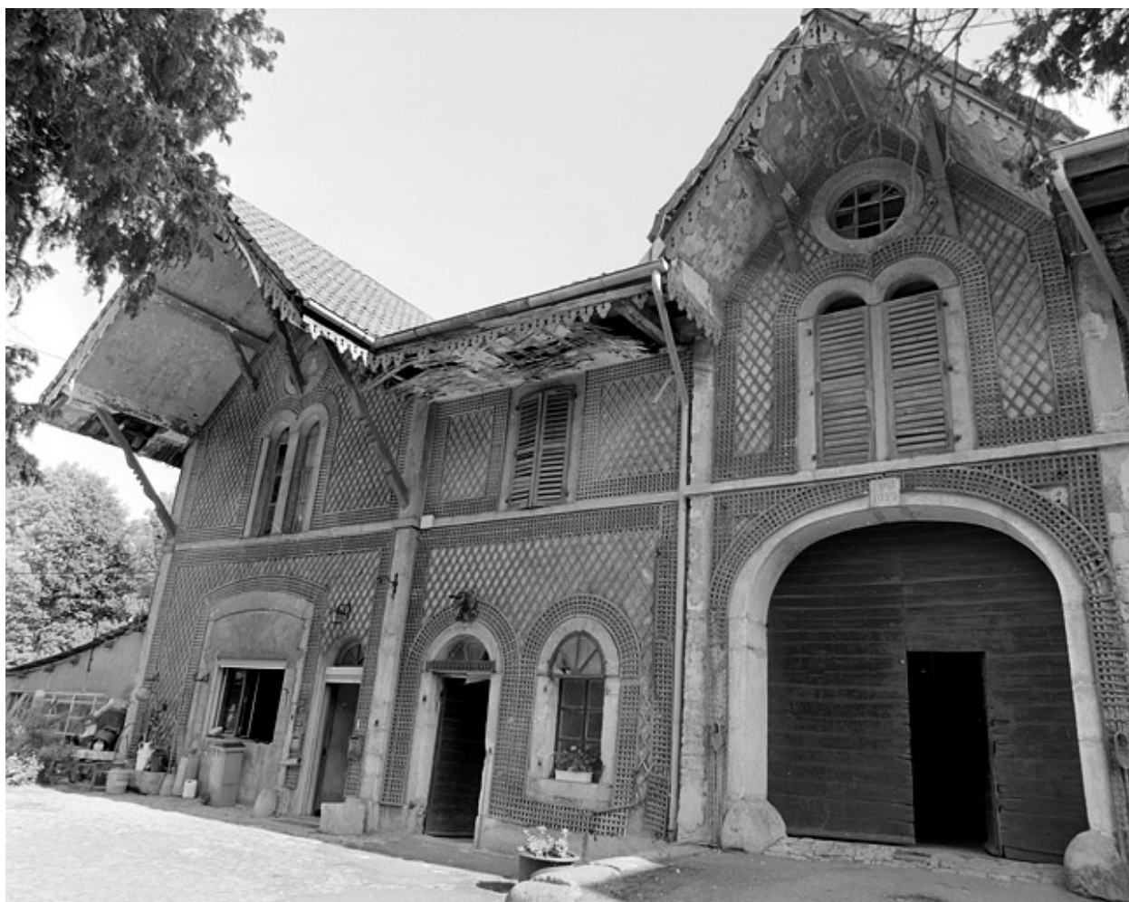
Façade antérieure de la ferme.
