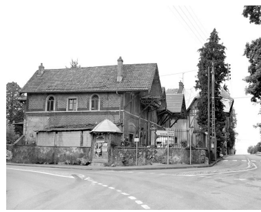
Façade orientale de la ferme. Phot. Yves Sancey IVR43_20029000287X
