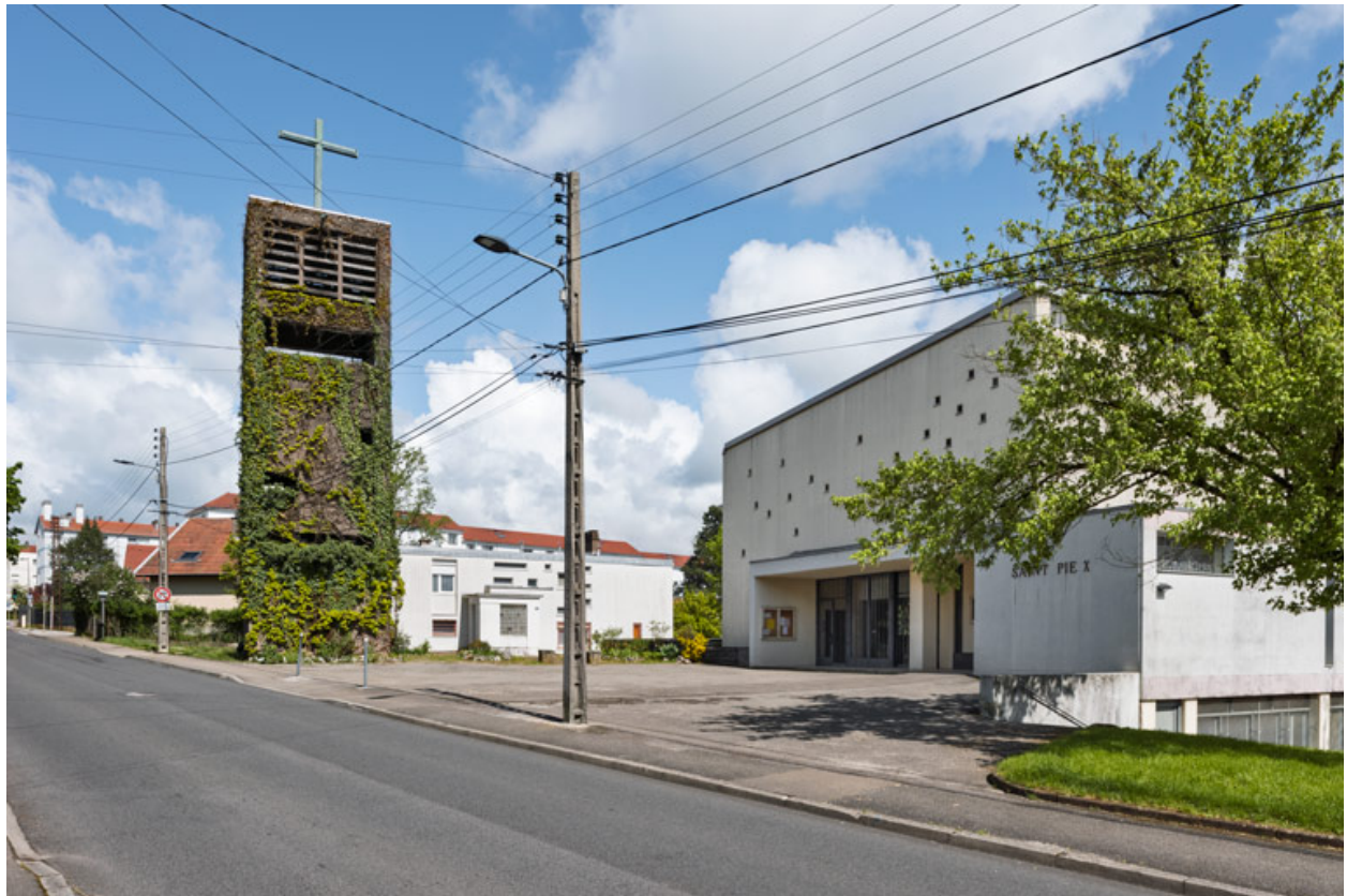
Place-parvis. Vue d'ensemble, de trois quarts.
