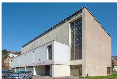
Façades sud-est et sud-ouest. Vue de trois quarts. Phot. Aline Thomas IVR43_20212500343NUC4A
