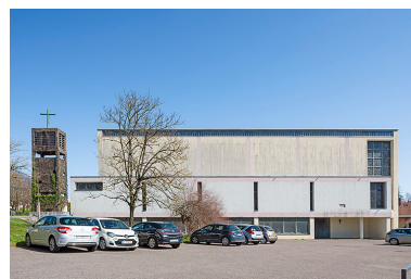
Façade sud-ouest. Vue d'ensemble. Phot. Aline Thomas IVR43_20212500344NUC4A
