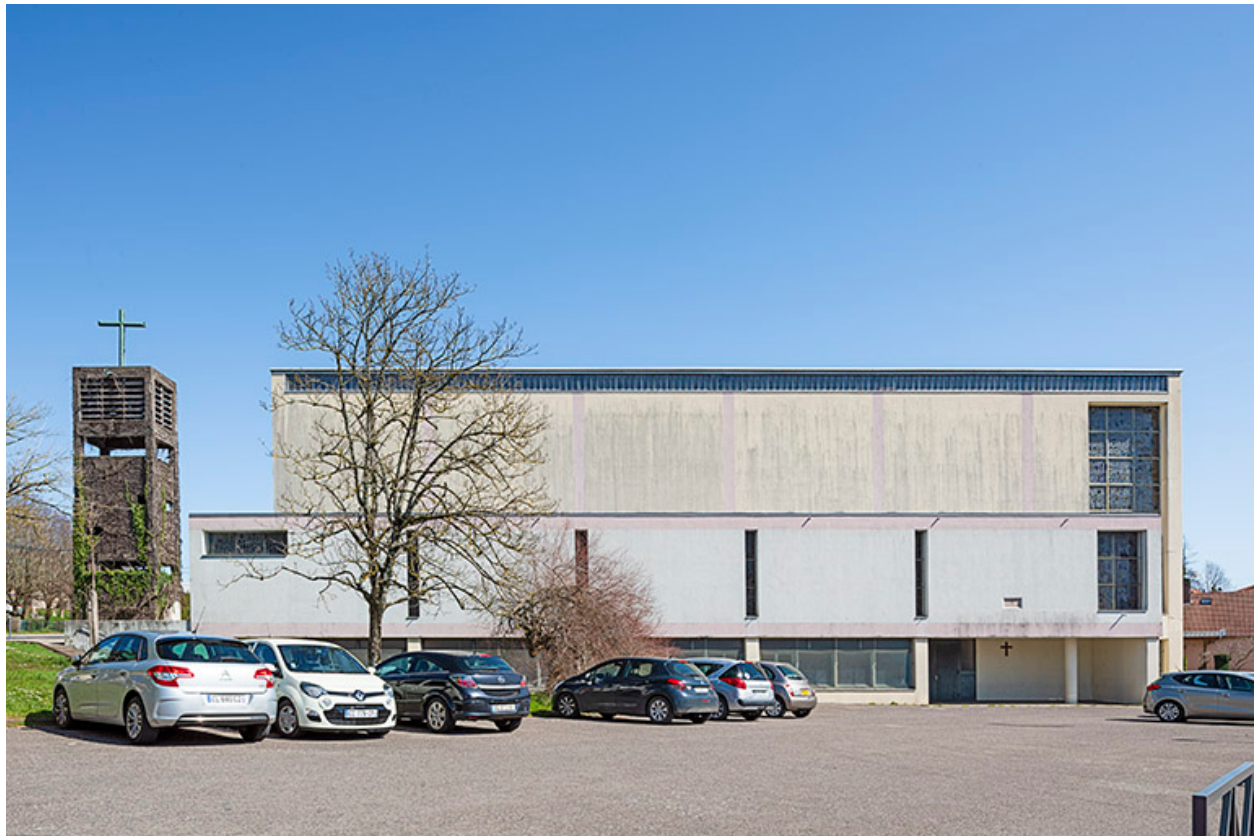
Façade sud-ouest. Vue d'ensemble.
