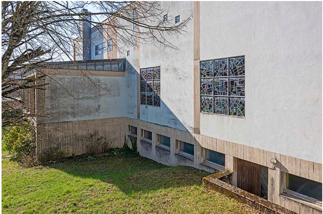
Façade nord-est. Détail.
