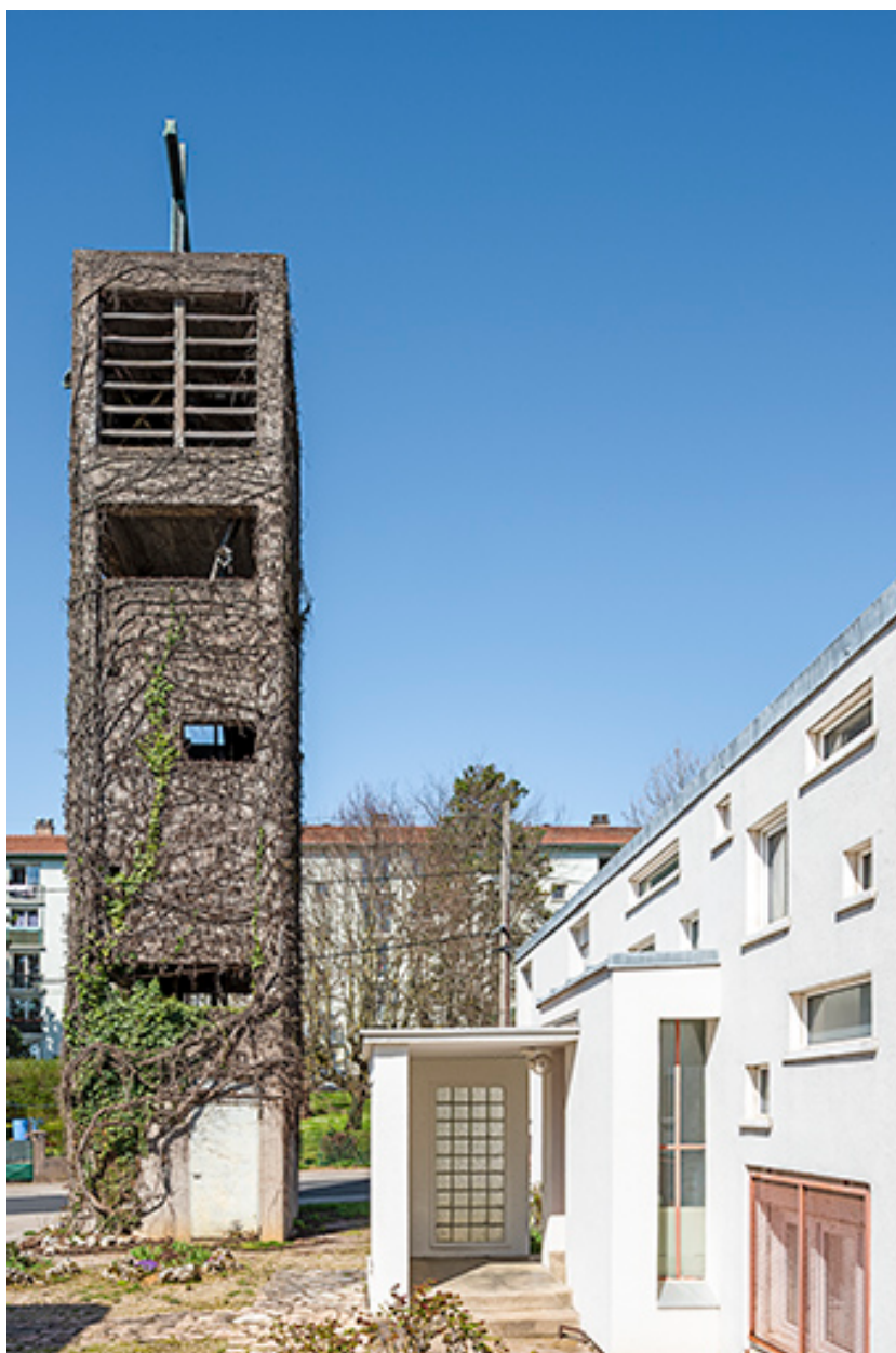
Clocher. Vue de la façade sud-est, à droite l'entrée du presbytère.
