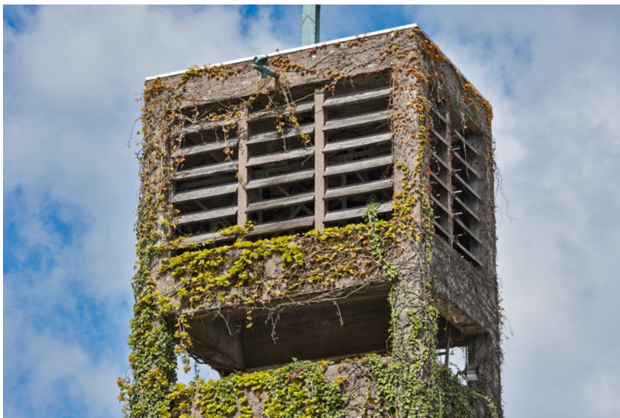
Clocher. Détail des abat-sons.
