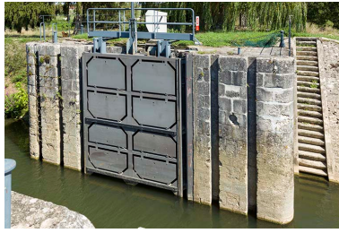
Vue d'un vantail. Phot. Sonia Dourlot IVR43_20157000809NUC2A
