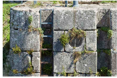
Rainure à batardeau (portière). Phot. Sonia Dourlot IVR43_20157000810NUC2A
