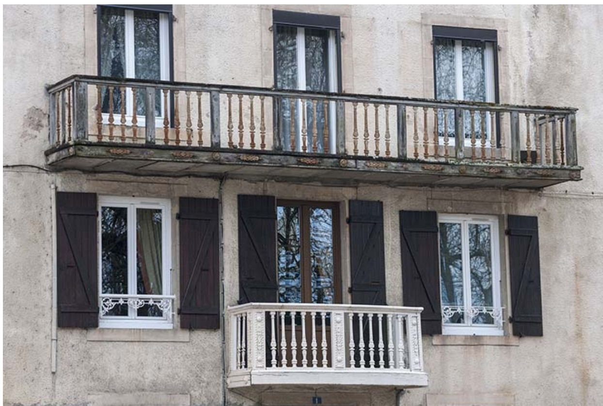
Façade latérale droite (avenue de la Gare) : les balcons à garde-corps en fonte.
