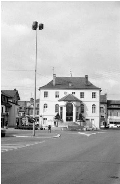
Vue de situation et façade postérieure.
