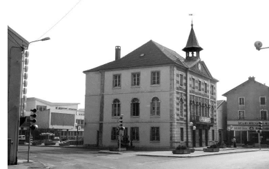
Façades antérieure et latérale droite.
