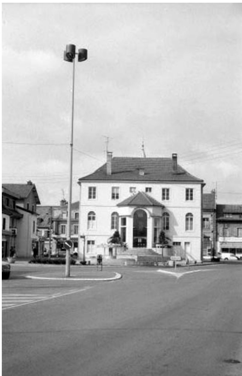
Vue de situation et façade postérieure.
