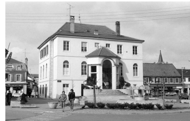
Façade postérieure. Phot. Bernard Lardière IVR43_19832500129Z
