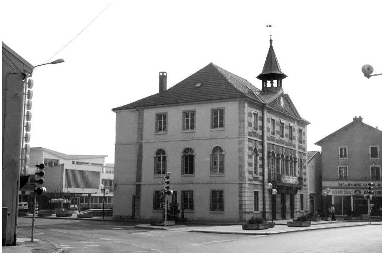
Façades antérieure et latérale droite.
