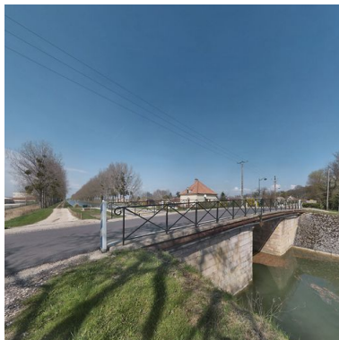
Vue d'ensemble, prise d'aval : remarquez le garde-corps.
