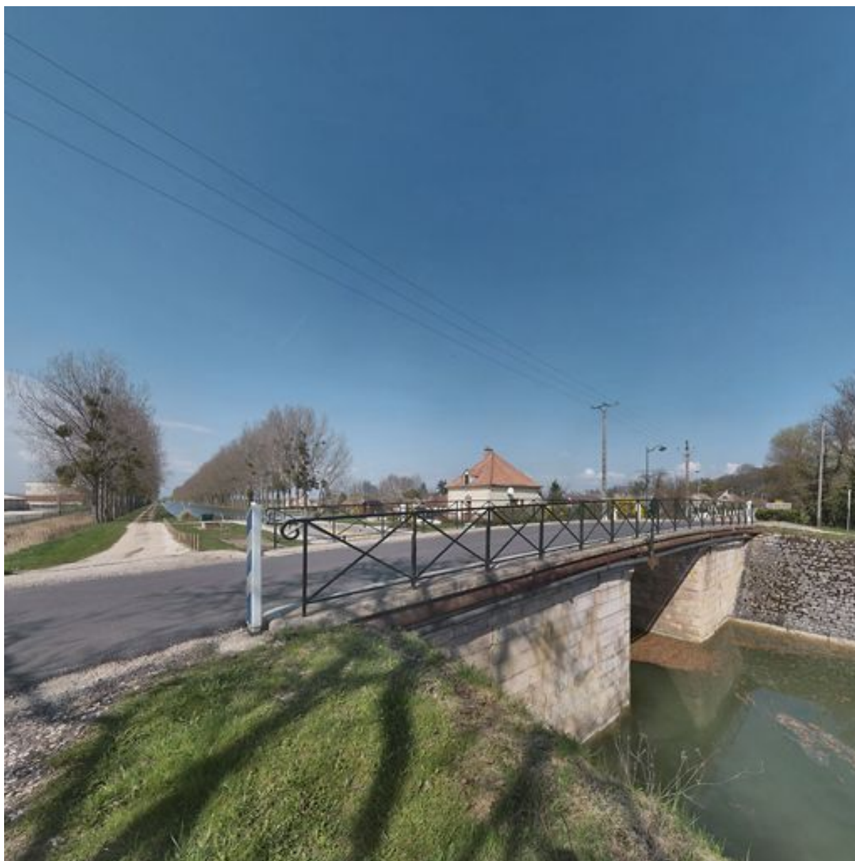
Vue d'ensemble, prise d'aval : remarquez le garde-corps.
