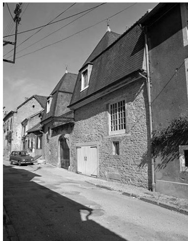
Vue générale depuis la rue. Phot. Yves Sancey IVR43_19802501400X
