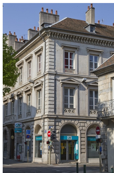
Logis principal : vue de l'angle sur rue.
