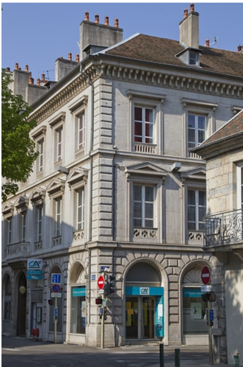
Logis principal : vue de l'angle sur rue.
