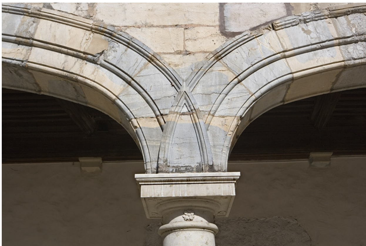
Détail d'un chapiteau du portique, de face.
