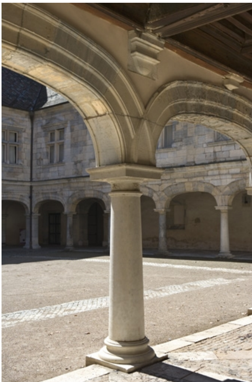
Détail du portique sud-ouest depuis le nord-ouest.
