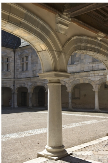
Détail du portique sud- ouest depuis le nord-ouest.
