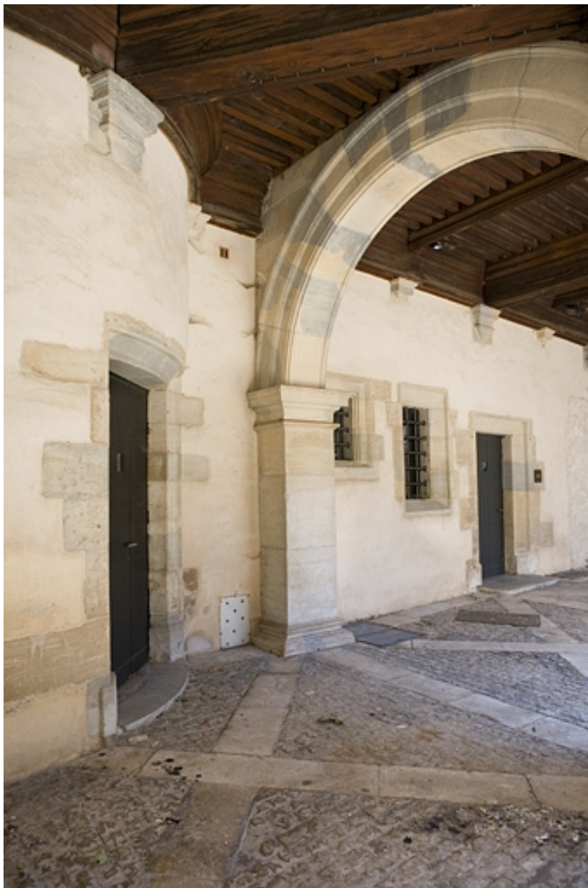
Détail de l'extrémité du portique nord-est.
