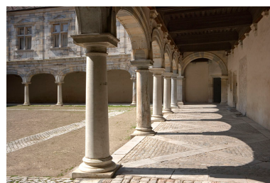
Vue d'une partie de la galerie nord-est.
