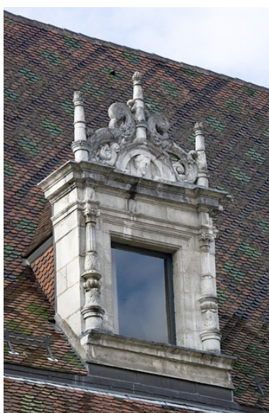
Détail d'une lucarne.
