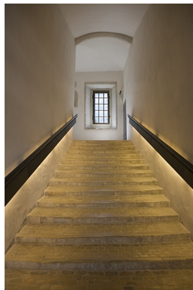
Escalier : première volée. Phot. Yves Sancey IVR43_20092501035NUC2A
