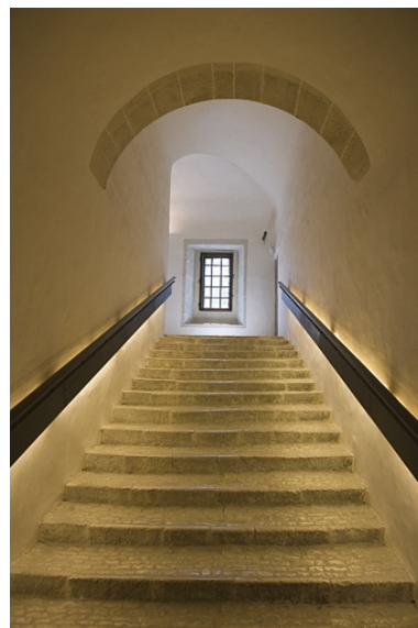
Escalier : troisième volée. Phot. Yves Sancey IVR43_20092501040NUC2A
