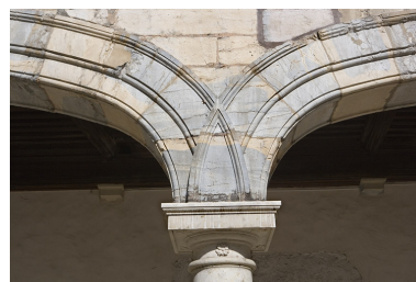
Détail d'un chapiteau du portique, de face.
