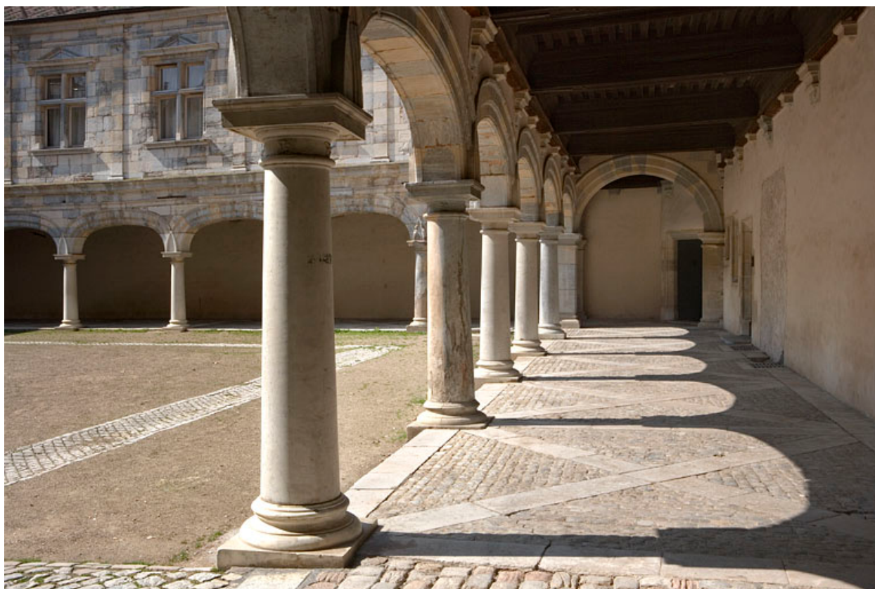
Vue d'une partie de la galerie nord-est.
