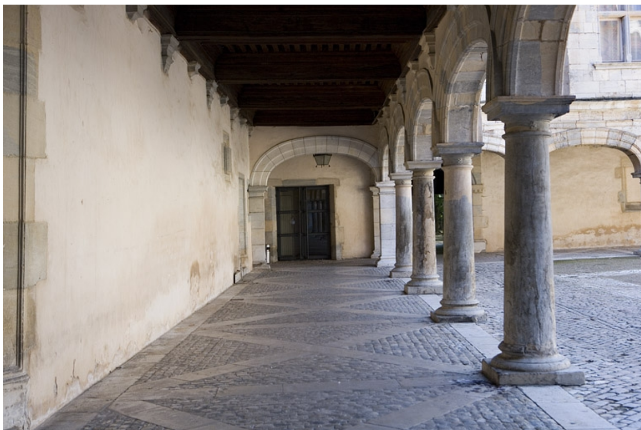
Vue du portique depuis le portail d'entrée.
