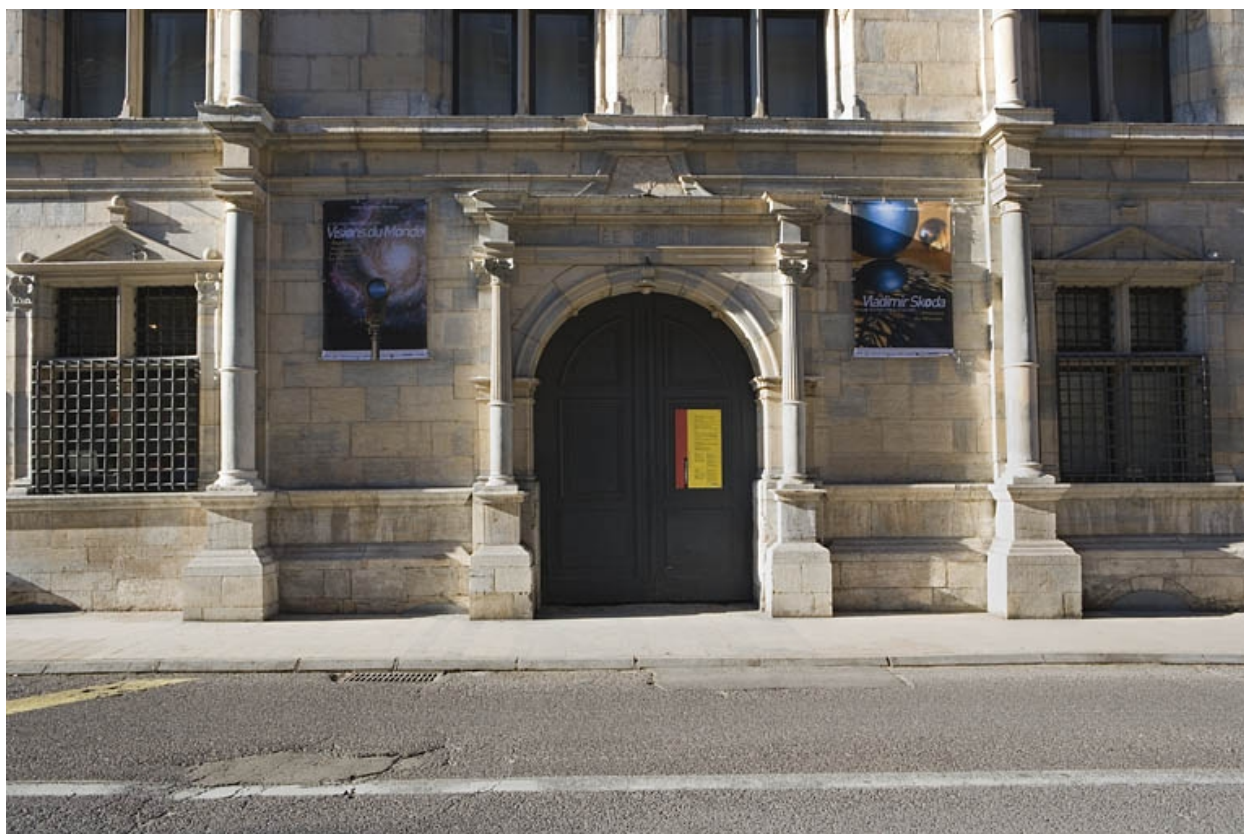
Façade principale : détail du portail d'entrée.
