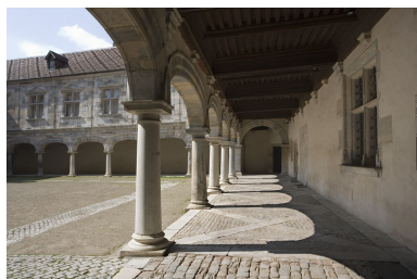
Vue d'ensemble de la galerie nord-est.
