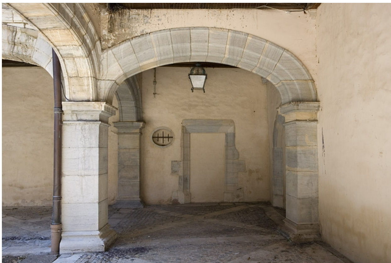
Détail de l'angle ouest du portique.
