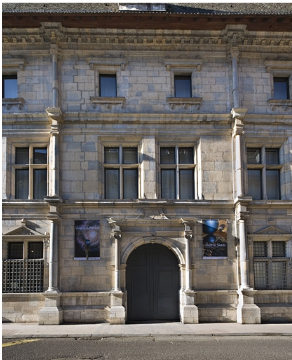
Façade principale : détail de la travée centrale.
