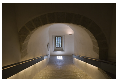
Escalier : quatrième volée depuis le haut. Phot. Yves Sancey IVR43_20092501041NUC2A
