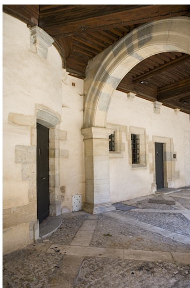
Détail de l'extrémité du portique nord-est.
