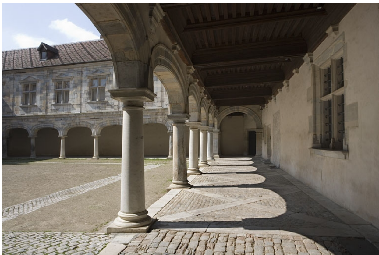
Vue d'ensemble de la galerie nord-est.
