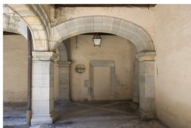
Détail de l'angle ouest du portique.
