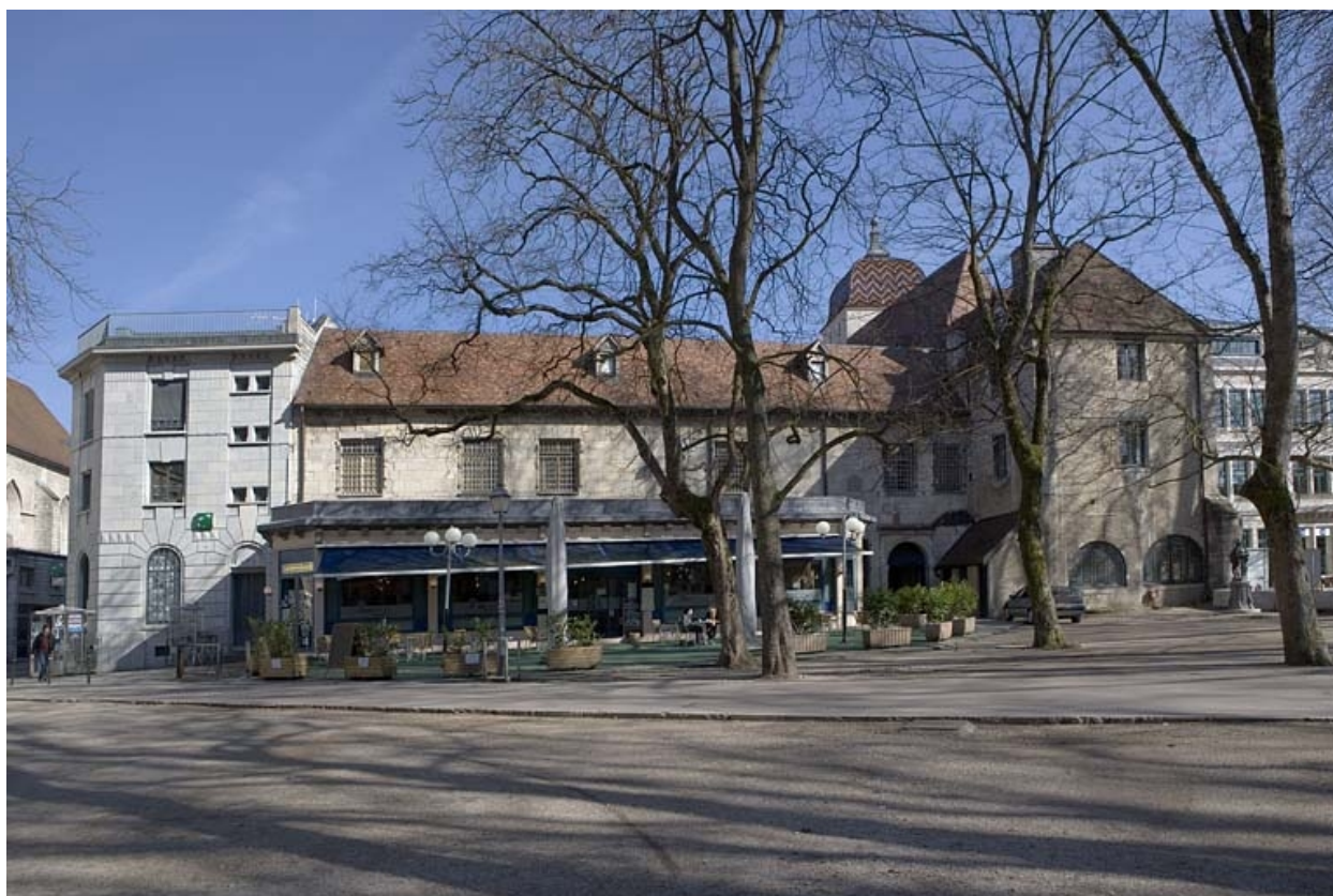
Vue d'ensemble de la façade postérieure.
