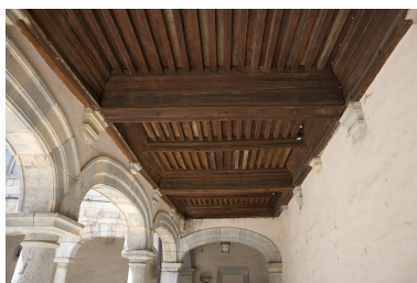
Détail du plafond à la française du portique.
