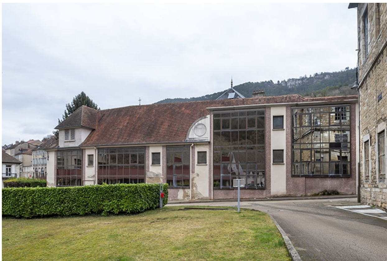
Façade sur la rue des Barres.
