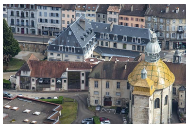
Vue depuis l'ouest. Phot. Jérôme Mongreville IVR43_20223900303NUC4A
