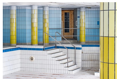
Rez-de-chaussée, piscine. Phot. Jérôme Mongreville IVR43_20213900226NUC4A
