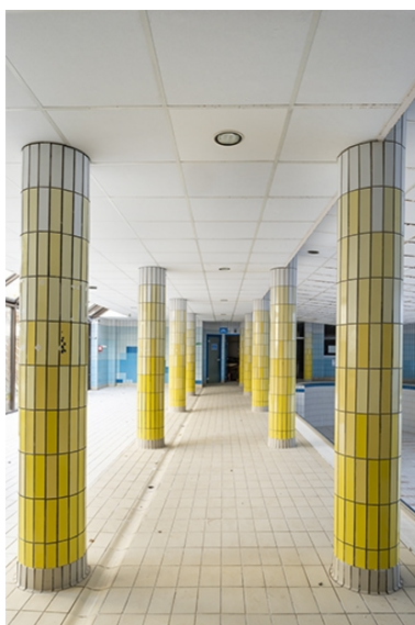
Rez-de-chaussée, piscine. Phot. Jérôme Mongreville IVR43_20213900223NUC4A
