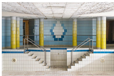
Rez-de-chaussée, piscine. Phot. Jérôme Mongreville IVR43_20213900225NUC4A
