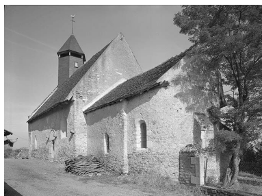
Elévation droite et abside. Phot. Jean-Luc Duthu IVR26_19945800364V
