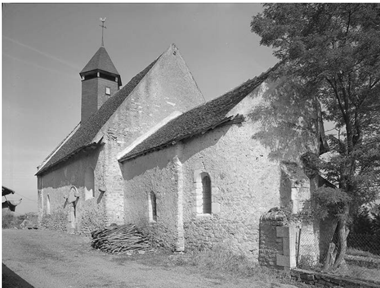
Elévation droite et abside.
