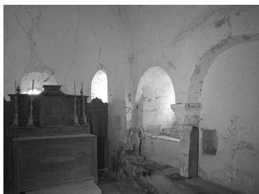
Mur droit du choeur. Phot. Jean-Luc Duthu IVR26_19945800370V
