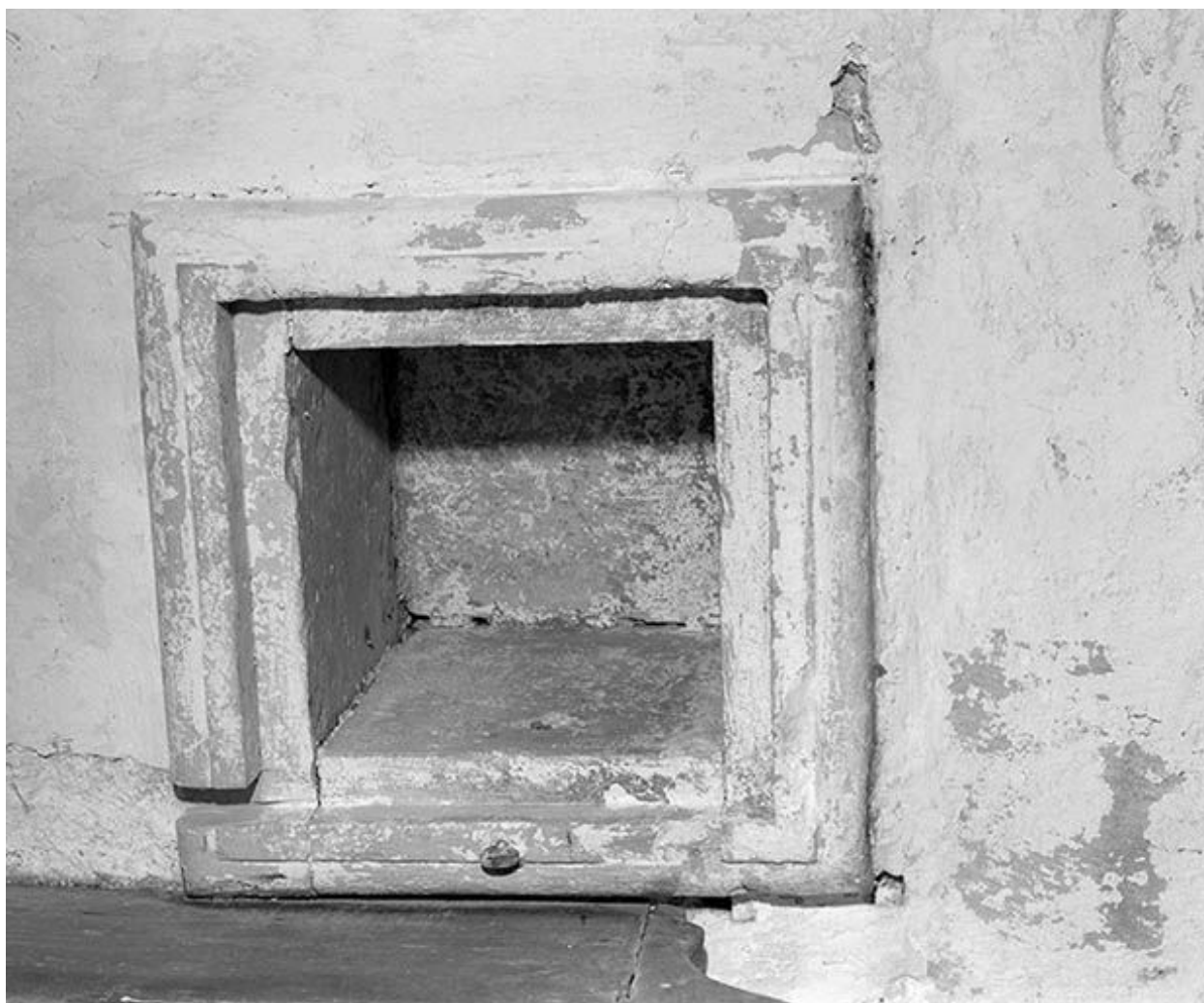
Niche du mur gauche du chœur.
