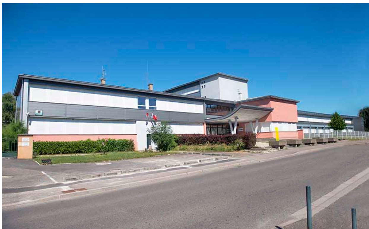
Façade antérieure sur rue.
