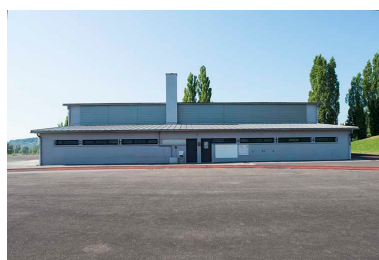
Façade antérieure du gymnase Phot. Mary Ruffinoni IVR43_20137000640NUC4A
