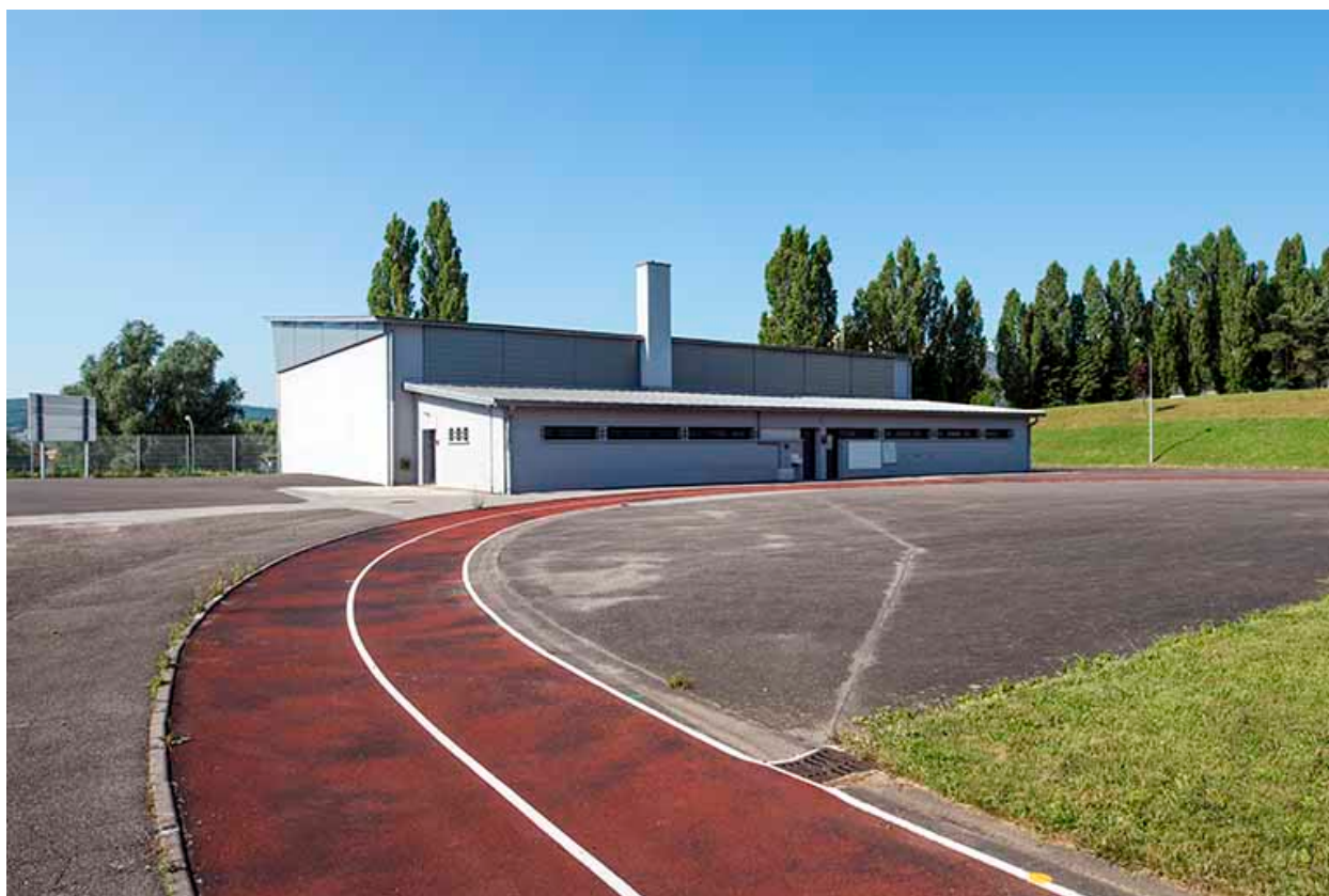
Angle nord-est du gymnase.
