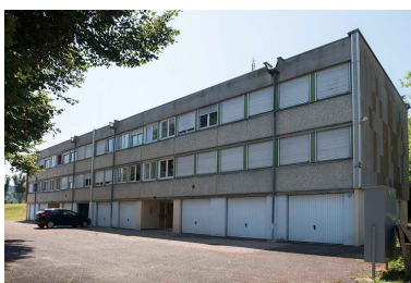
Angle nord-ouest des logements. Phot. Mary Ruffinoni IVR43_20137000645NUC4A
