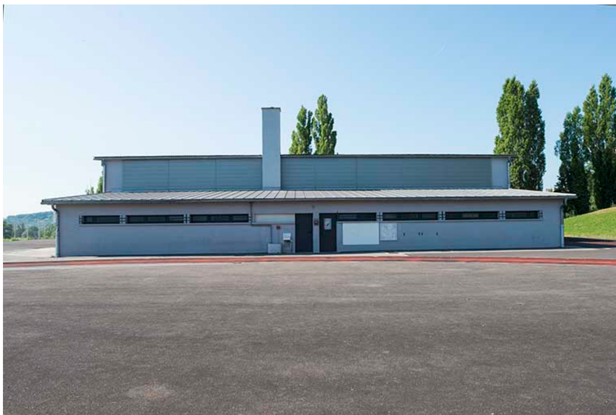
Façade antérieure du gymnase
