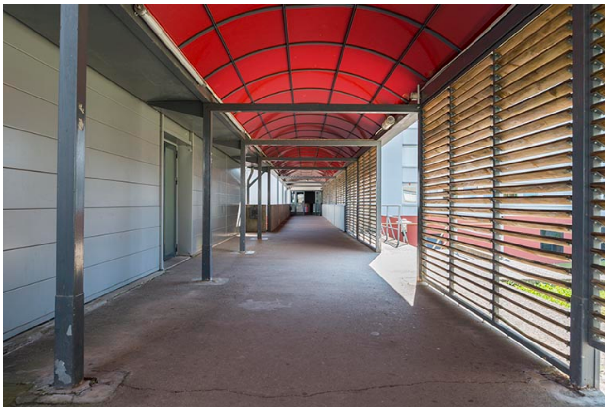
Détail des circulations abritées.
