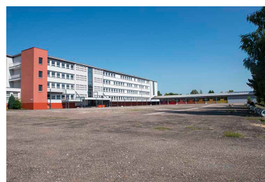
Cour devant les préaux et l'externat. Phot. Mary Ruffinoni IVR43_20137000659NUC4A
