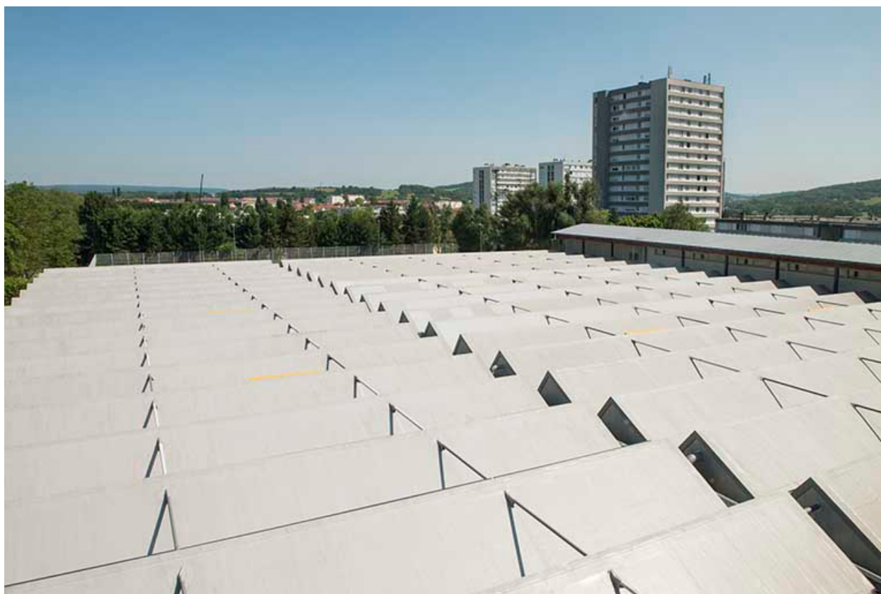
Couverture en sheds des ateliers.
