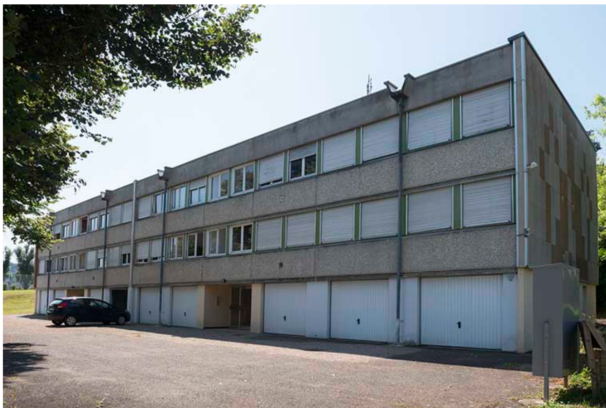
Angle nord-ouest des logements.
