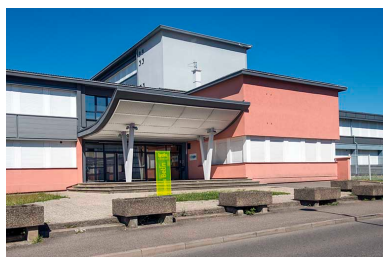
Détail de l'entrée principale. Phot. Mary Ruffinoni IVR43_20137000654NUC4A
