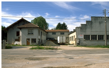
Façades antérieures. Phot. Yves Sancey IVR43_19973901288ZA
