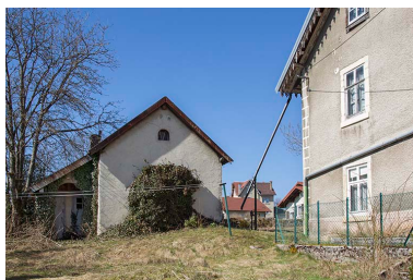
Tuyau d'alimentation de la citerne et dépendance. Phot. Sonia Dourlot IVR43_20152500804NUC2A
