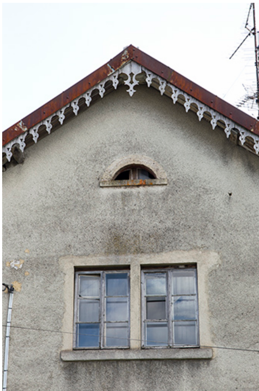
Façade latérale droite : pignon avec fenêtre horlogère.
