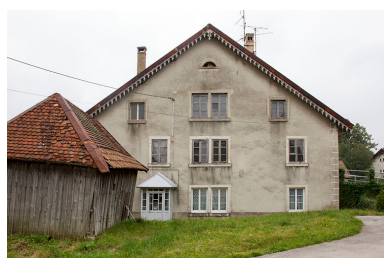
Façade latérale droite. Phot. Yves Sancey IVR43_20132503015NUC2A
