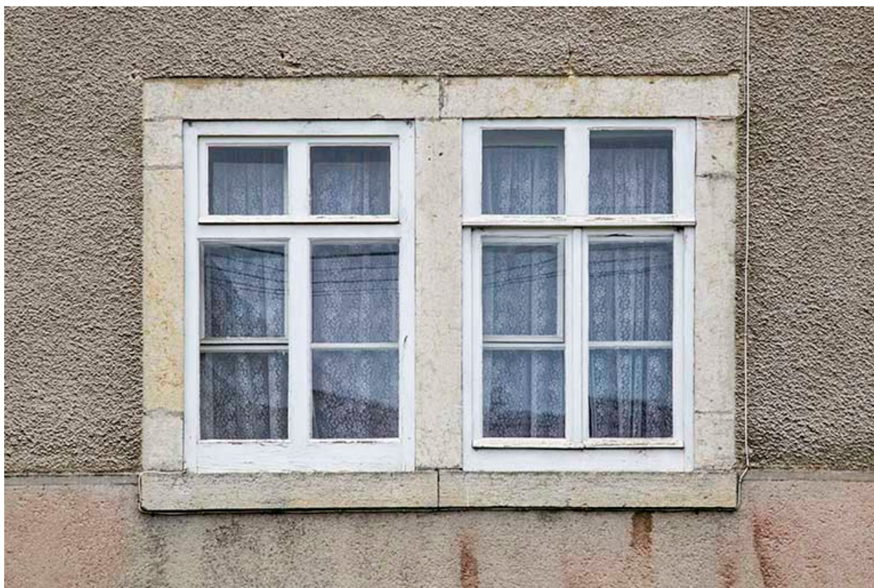
Façade latérale gauche : fenêtre horlogère.
