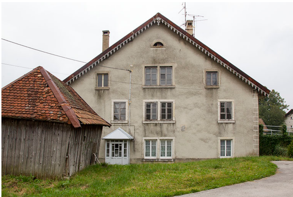
Façade latérale droite.
