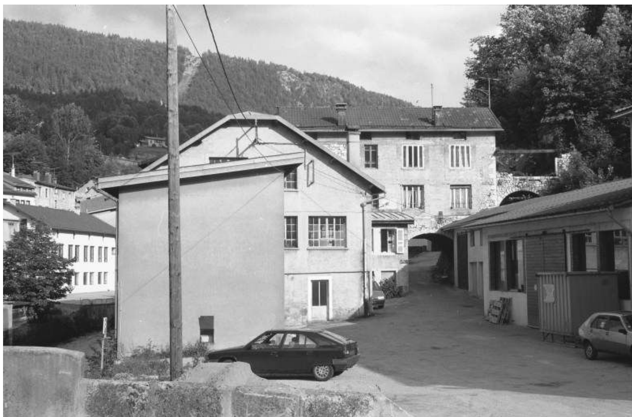
Vue d'ensemble depuis le nord-ouest (aval).
