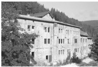
Façade sur la Bienne depuis l'est (amont). Phot. Laurent Poupard IVR43_19913901516Z
