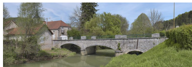
Pont en pierre sur l'Ouche. Phot. Thierry Kuntz IVR26_20122102414NUC4AQ
