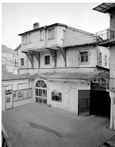
Théâtre et entrée de la remise d'automobile. Phot. Jérôme Mongreville IVR43_19933900019X
