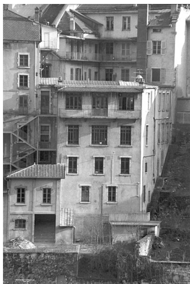
Café : façade postérieure. Phot. Jérôme Mongreville IVR43_19933900025Z
