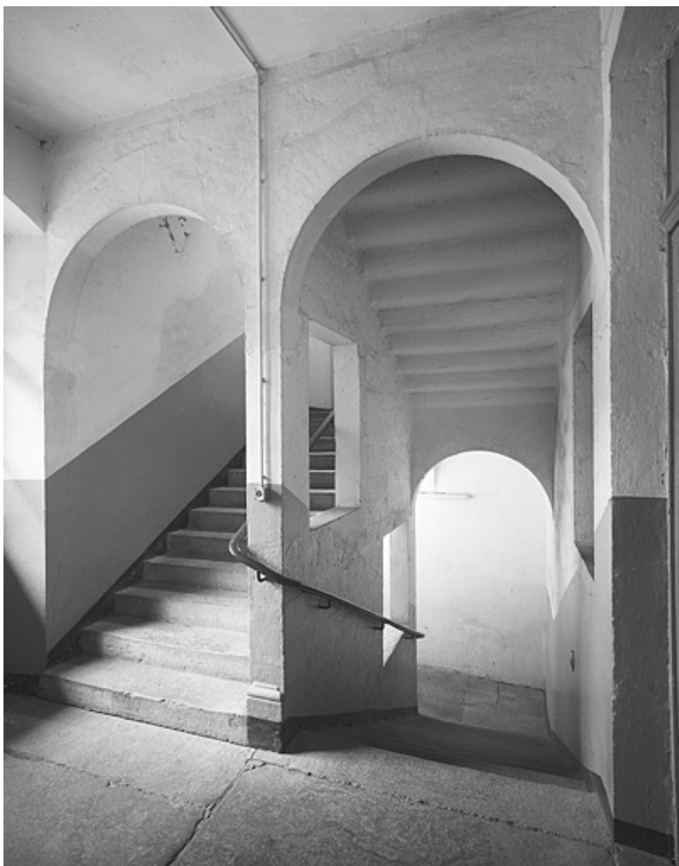
Bâtiment rue de la Poyat : escalier.
