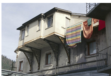
Cabine de projectionniste. Phot. Yves Sancey IVR43_20023900450ZA
