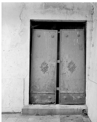
Porte dans la cour intérieure. Phot. Jérôme Mongreville IVR43_19923900566X
