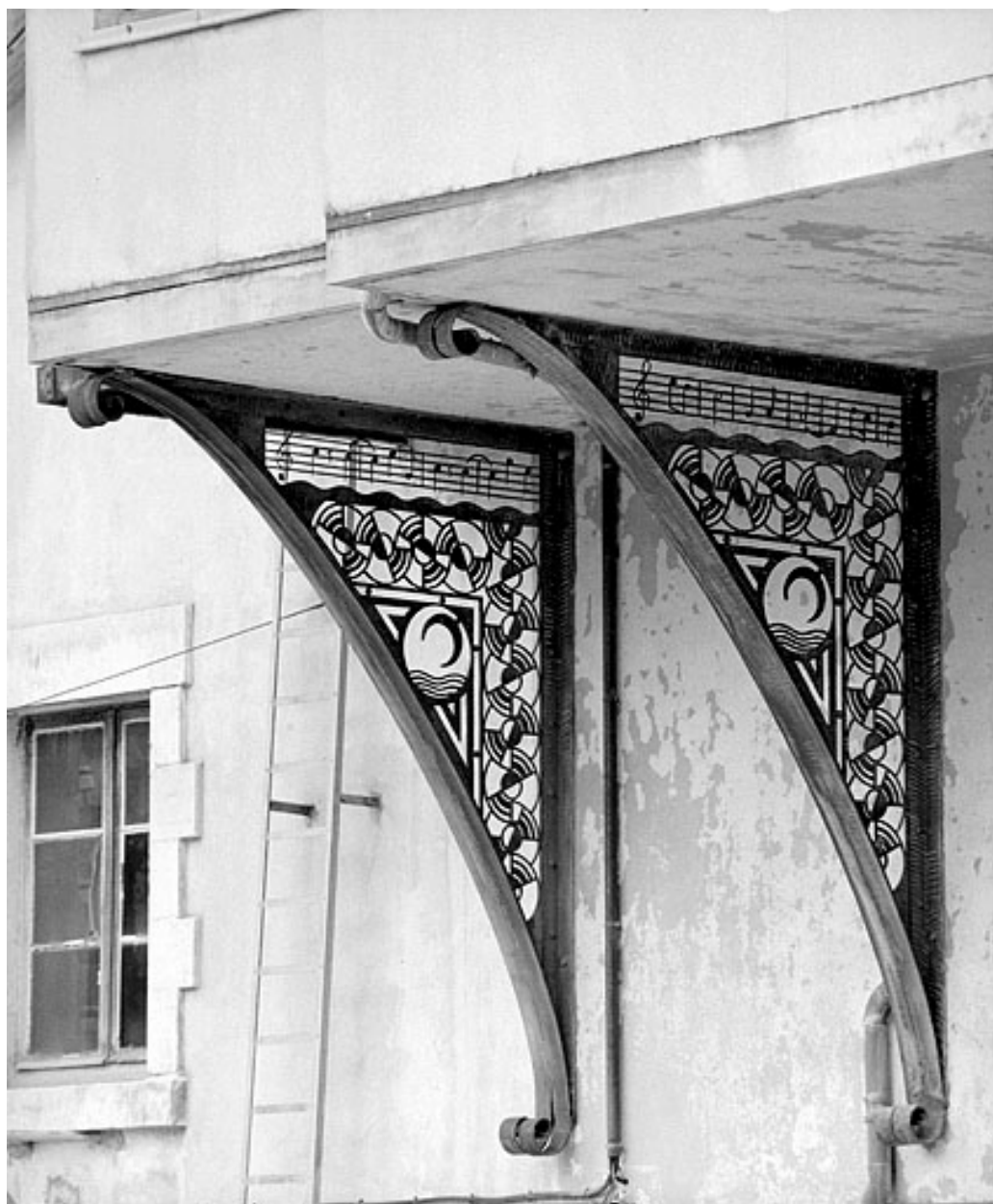
Consoles de la cabine de projectionniste.
