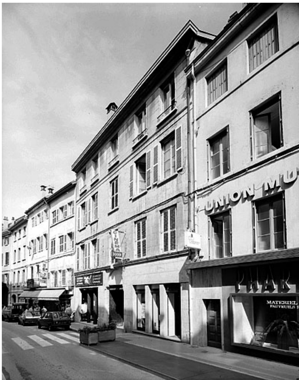
Bâtiment rue de la Poyat : façade antérieure.
