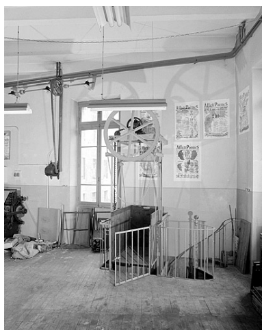
Ancien monte-charge de l'imprimerie. Phot. Jérôme Mongreville IVR43_19923900573X
