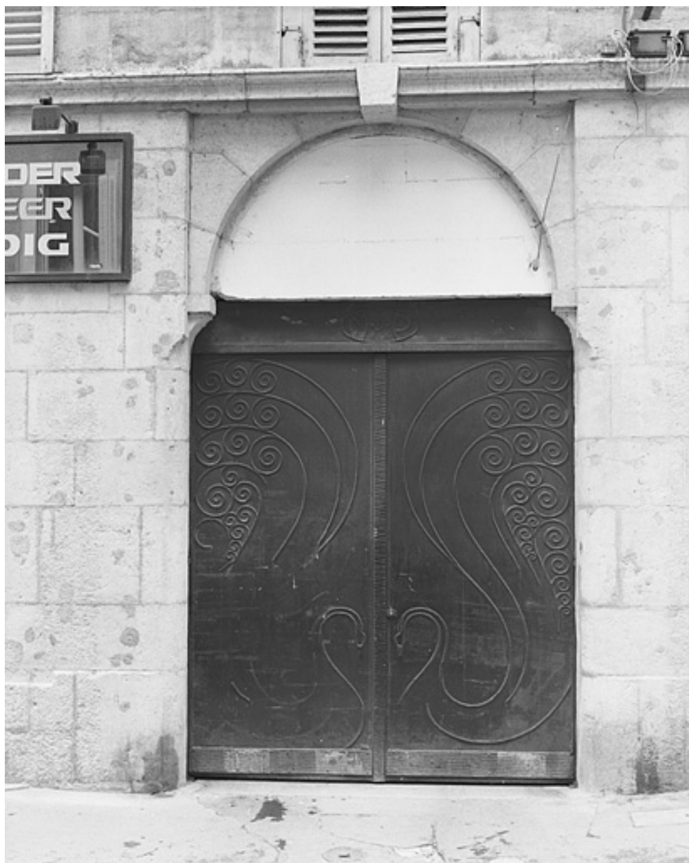
Bâtiment rue de la Poyat : portail d'entrée.
