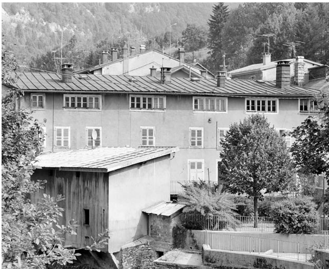
Façade principale : les deux étages carrés.
