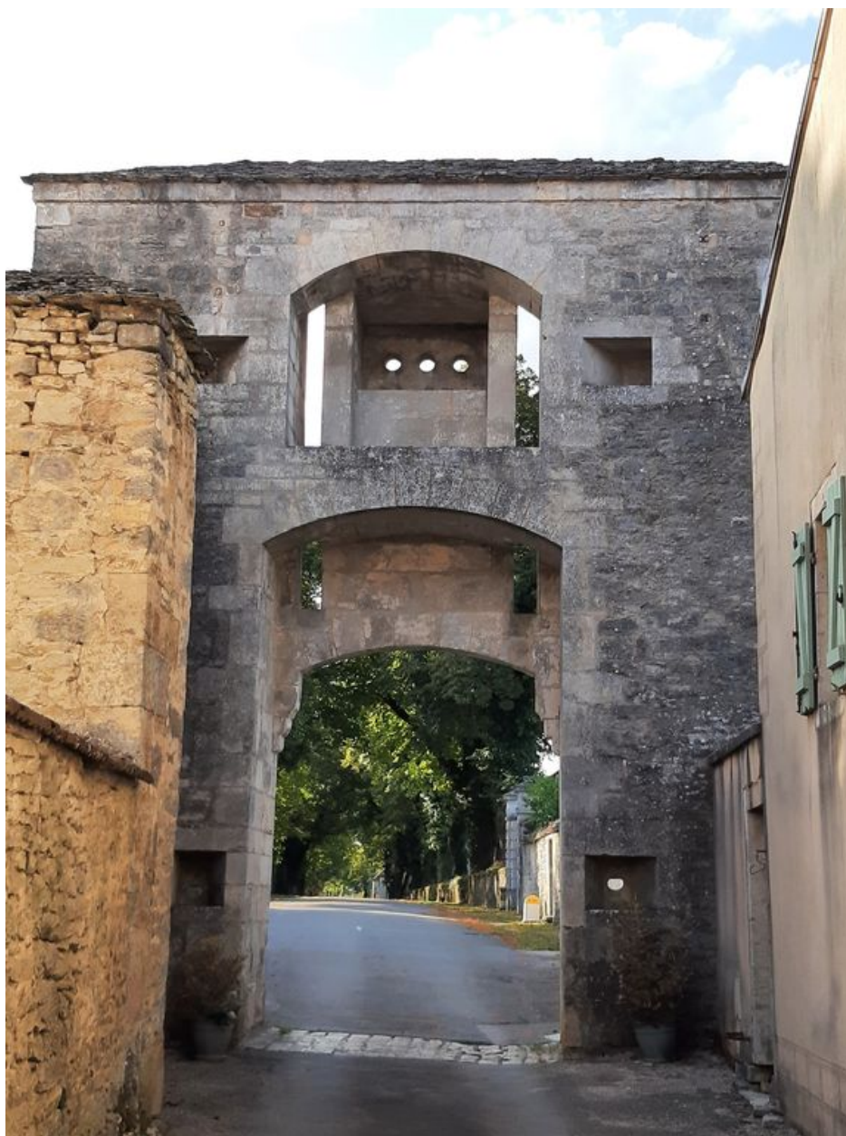
Vue intérieure de la porte de ville, depuis le sud-est.
