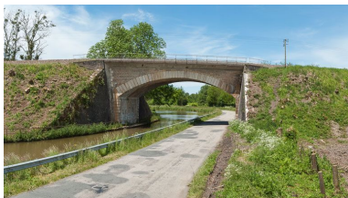
Le pont, vu d'amont. Phot. Pierre-Marie Barbe-Richaud IVR26_20137100409NUC2AQ
