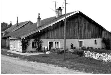
Façade antérieure en 1975. Phot. Gilbert Poinot IVR43_19752500768Z
